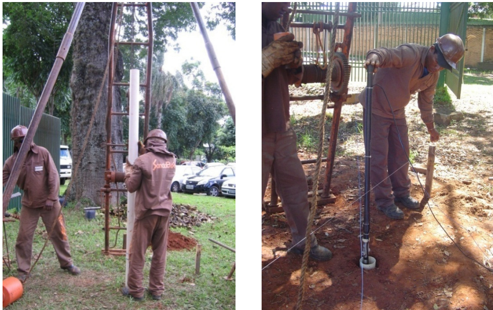
Figura 5.13 – Colocação do tubo de PVC para a proteção da instrumentação
