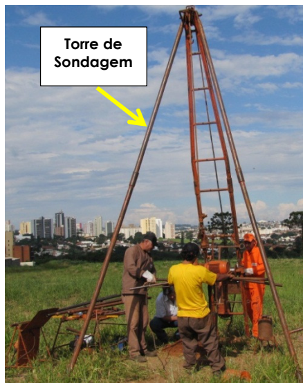
(a) Torre de sondagem completa
