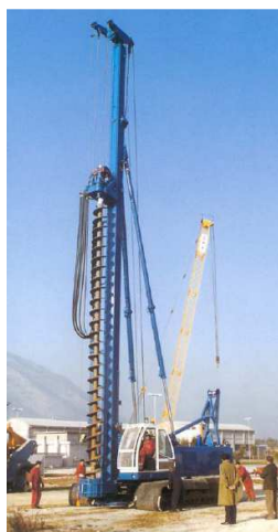
Figura 2.1– Equipamento de execução de estacas hélice contínua.(CMV, 2000 apud BARRETO, 2005)
