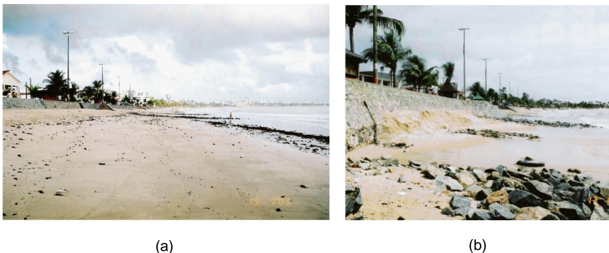
Figura 4.5 Perfil praias de trecho da praia de Manaíra em janeiro de 2005 (a) e em junho de 2005 (b) (as rochas aflorando são na verdade de obras anteriores de contenção do processo erosivo – na foto (a) elas se encontram soterradas pelos sedimentos). Furrier (2007).
