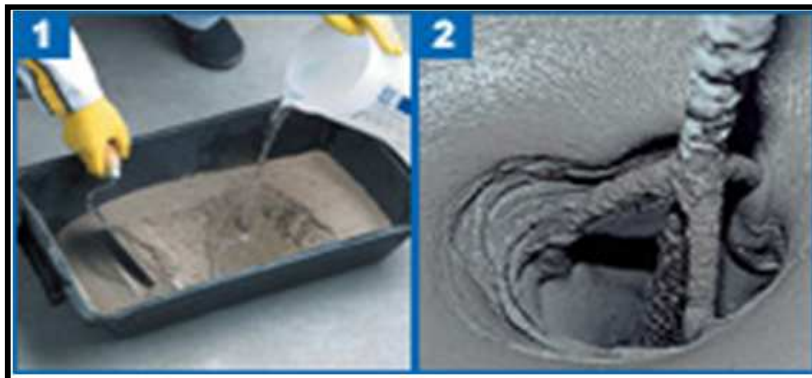
Figura 3.7 – Preparação do graute (Supergraute- Quartzolit)
