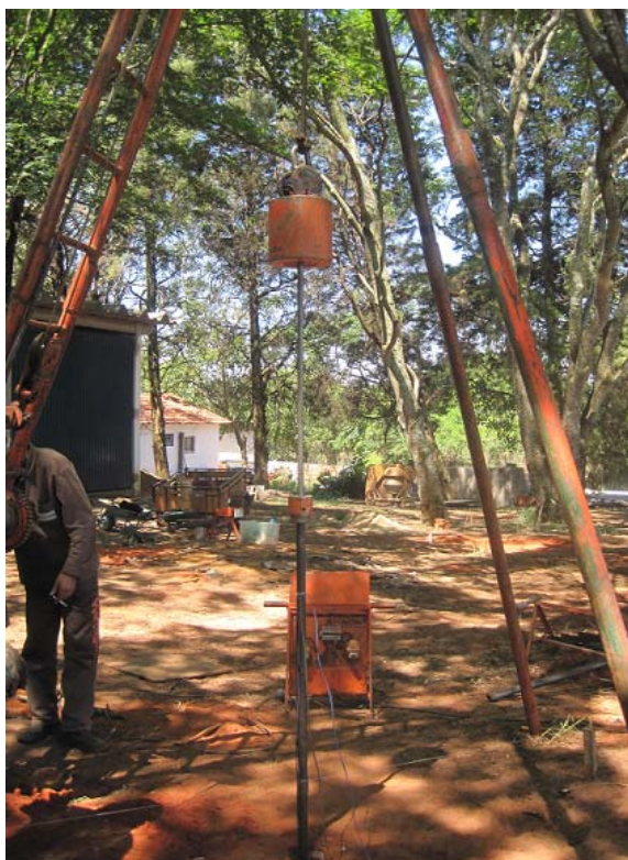
Figura 3.12-Ensaio SPT5_C2 utilizando massa do martelo 65 kg.
