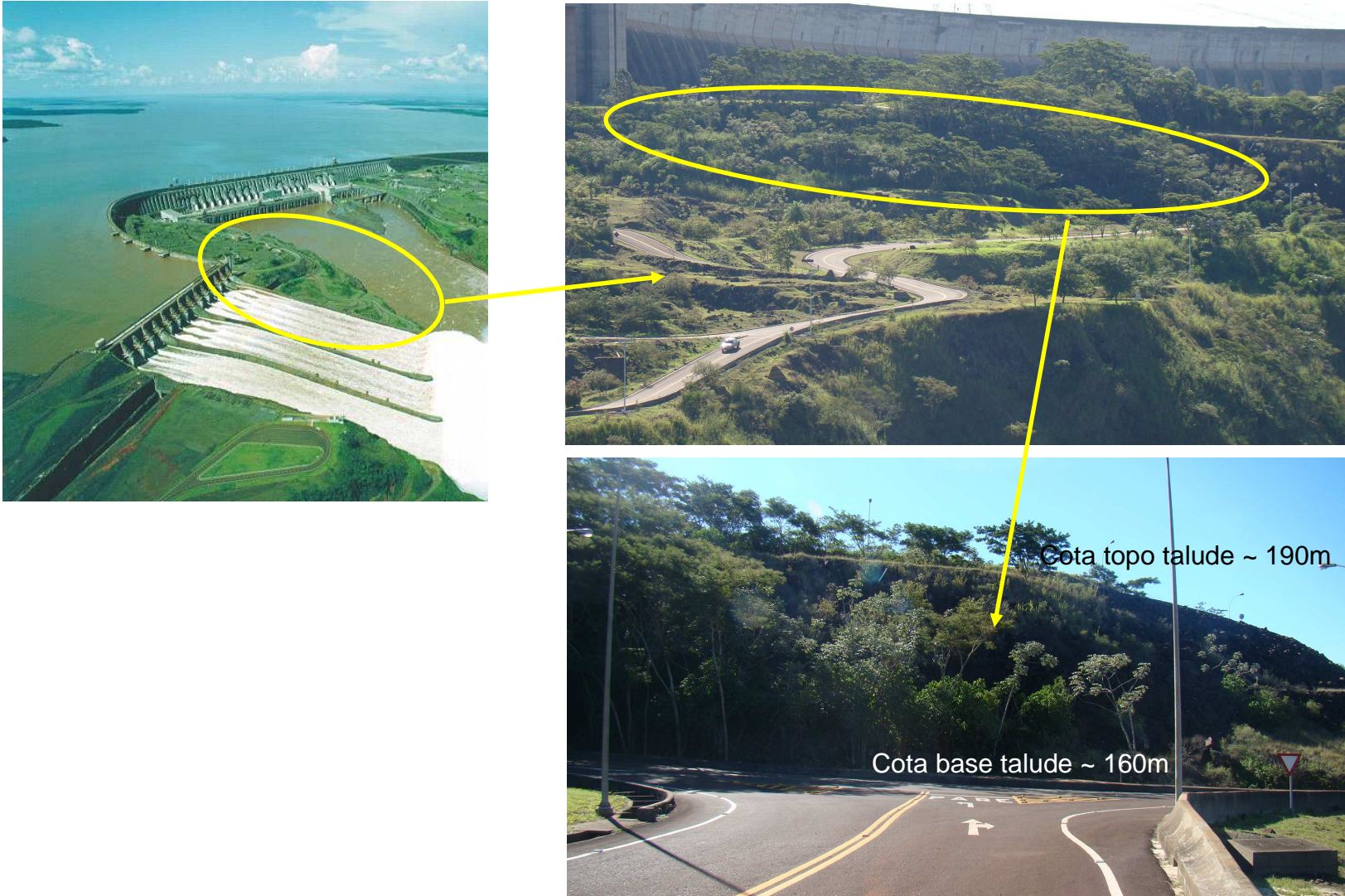
Figura 134 – Afloramento das feições do derrame D na lateral esquerda do vertedouro.
