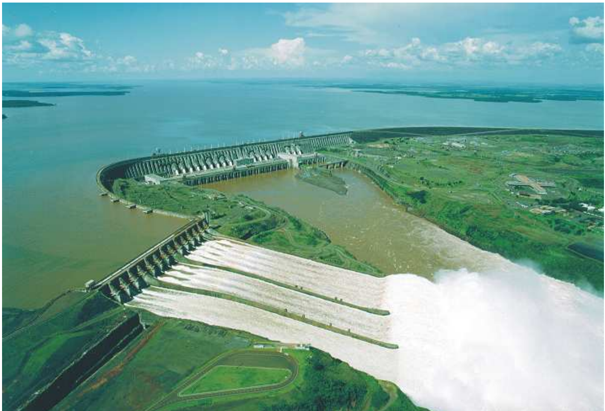
Figura 2 – Vista da barragem de Itaipu com vertedouro em operação.
