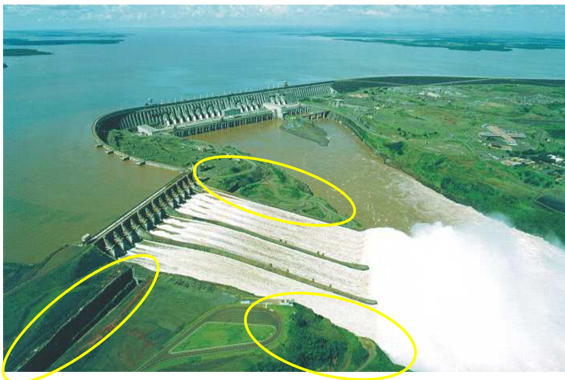
Figura 132 – Imagem da Barragem de Itaipu com destaque para as zonas de escavação localizadas na lateral do Vertedouro e a jusante da Barragem de Terra Direita.
