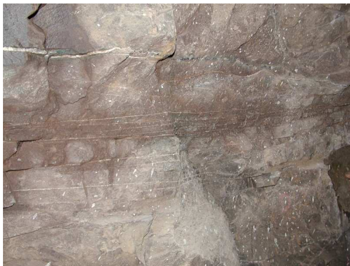
Figura 47 – Descontinuidade B localizada no túnel de exploração e drenagem (cota 61 m) executado a margem esquerda do rio Paraná – feixe de fraturas.
