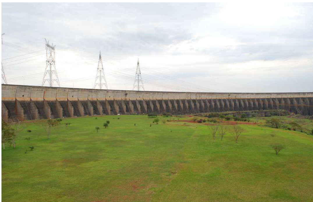
Figura 112 – Vista a jusante da Barragem Lateral Direita.
