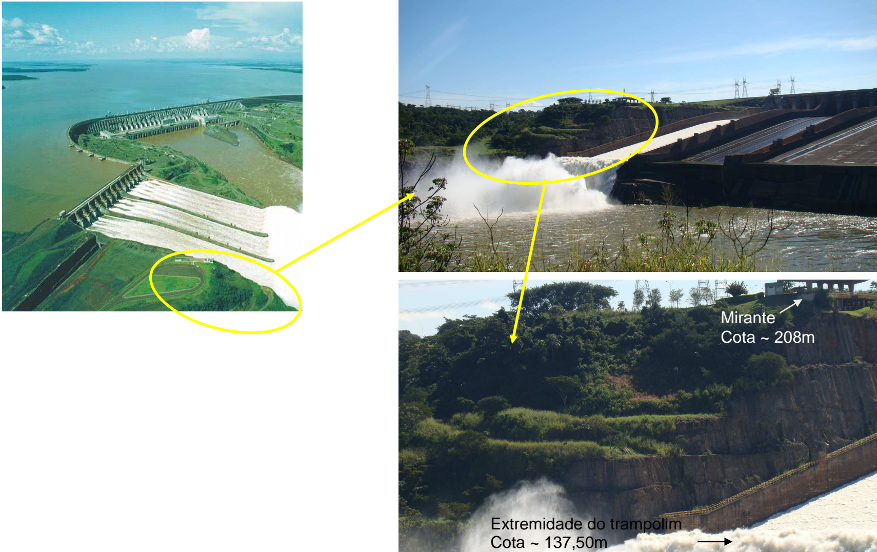
Figura 133 – Afloramento das feições do derrame D na lateral direita do vertedouro.
