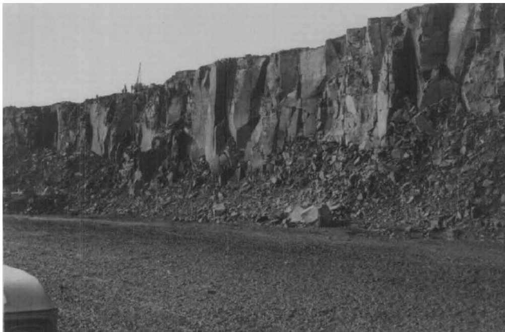
Figura 45 – Derrame E – escavação canal de desvio do rio Paraná.
