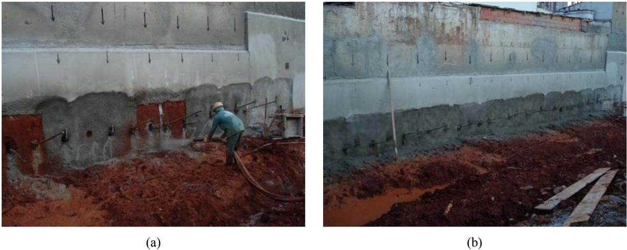
**Figura 3.53. (a) Jateamento de concreto projetado e (b) vista dos chumbadores executados.**
