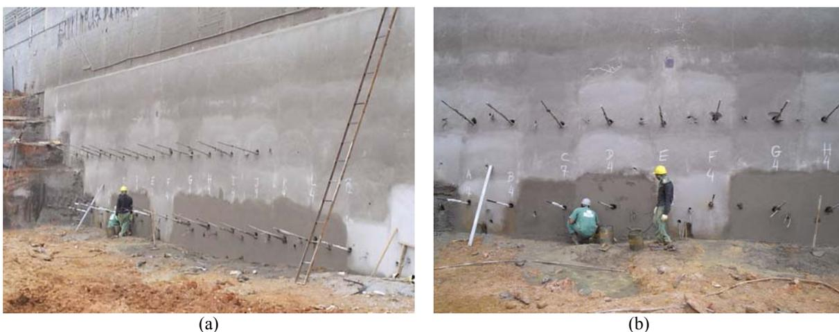
**Figura 3.64. (a) Vista geral e (b) detalhada da cortina de solo pregado após a realização dos chumbadores testes das linhas 3 e 5.**
