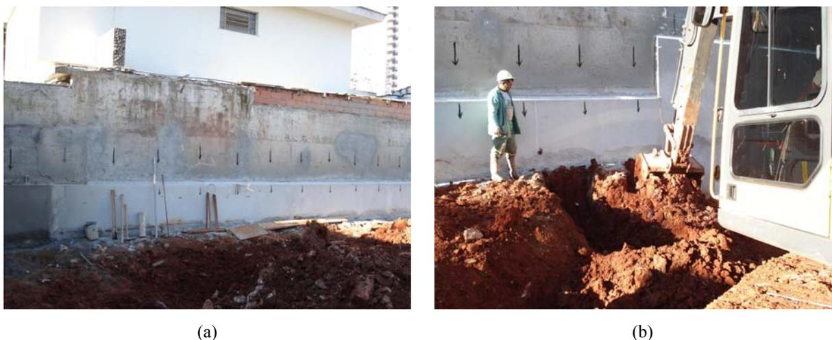
**Figura 3.51.** (a) Localização do trecho estudado após o termino da linha 1 de chumbadores e (b) detalhe da escavação, em nichos, para a realização da segunda linha de chumbadores.
