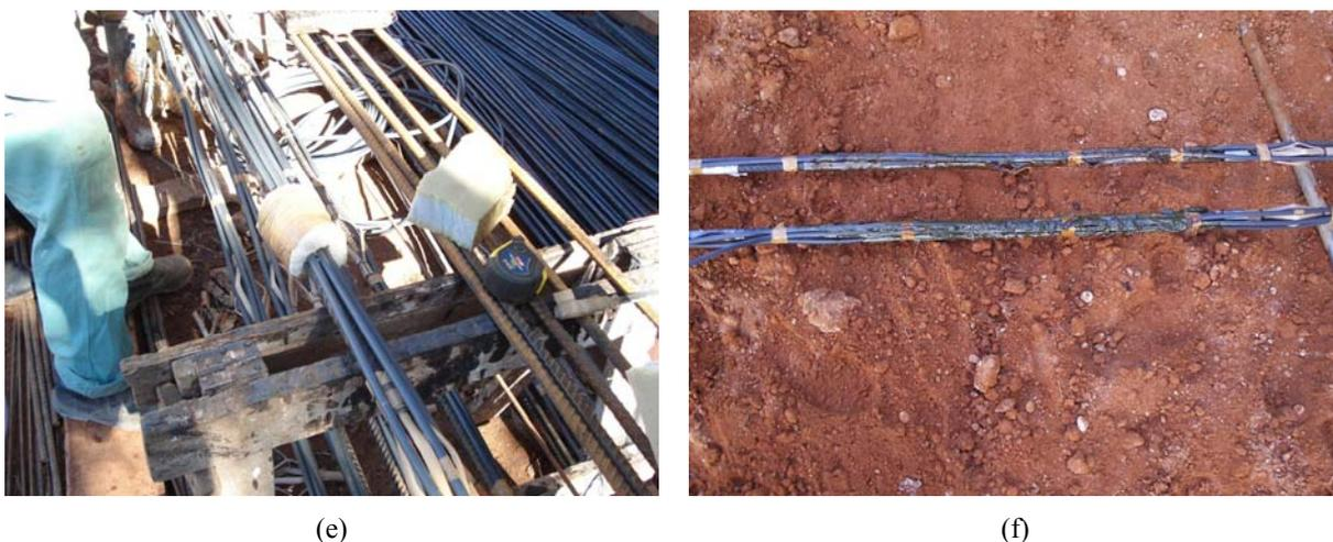
**Figura 3.50.** Detalhe da preparação das barras de aço. (a) Junção das barras de aço com luvas metálicas, (b) fixação de centralizadores a cada 0,5 m, (c) fixação dos tubos de injeção, (d) proteção das válvulas de injeção com fitas adesivas, (e) obturador de espuma enrolada no início do trecho livre e (f) proteção do trecho livre com mangueira plástica e graxa.
