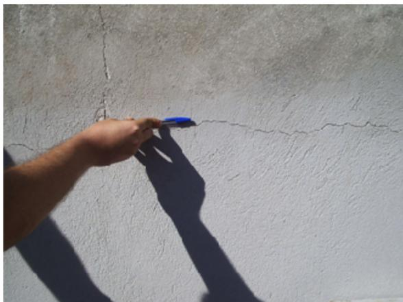
**Figura 3.68. Detalhe das trincas horizontais e verticais que surgiram durante a realização do ensaio.**
