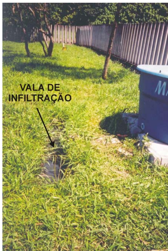
Figura 16.3-2 - Vala de infiltração de esgoto doméstico.
