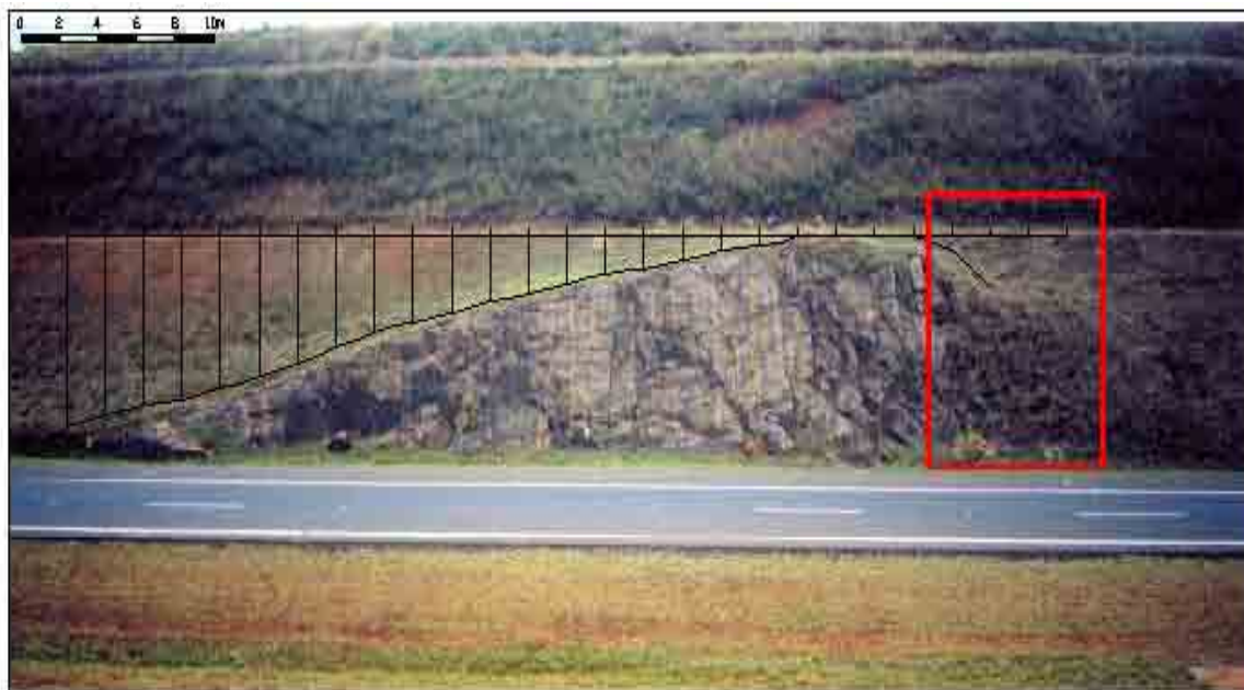
Figura 15.1-7 - Visão mais ampla do afloramento, mostrando uma pequena camada de solo no final do perfil, sobre o topo rochoso (destacada em vermelho).
