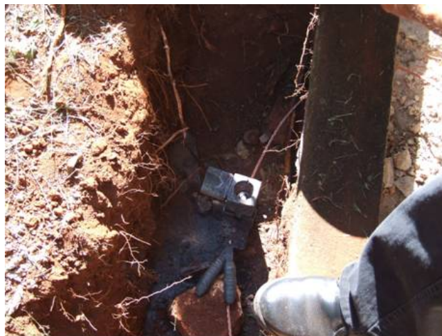
Figura 3.34 Interligação com cabo de cobre
