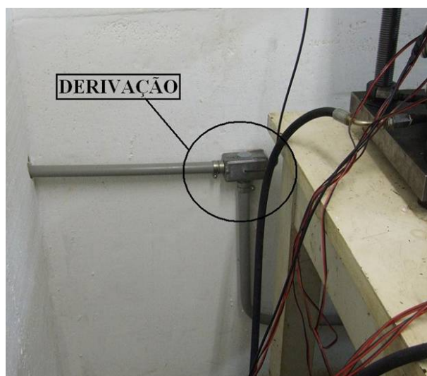
Figura 3.36 Derivação do fio terra
