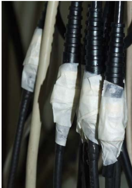
Figura 3.30 Detalhe dos cabos isolados com fita crepe
