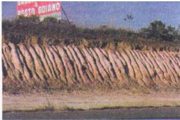
Figura 1. Feições erosivas do tipo sulcos (Camapum de Carvalho et al. , 2006)
