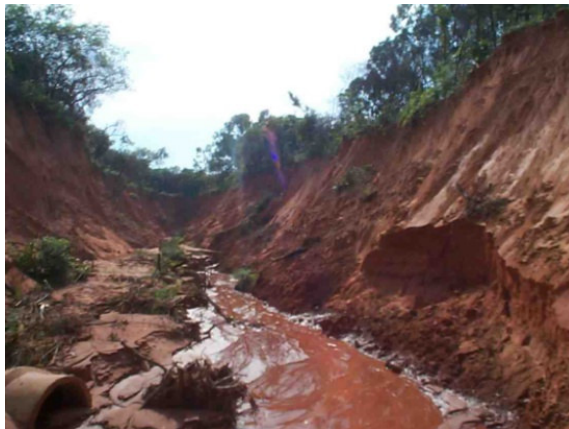
Figura 3. Feição erosiva do tipo voçoroca em Bauru (SP)
