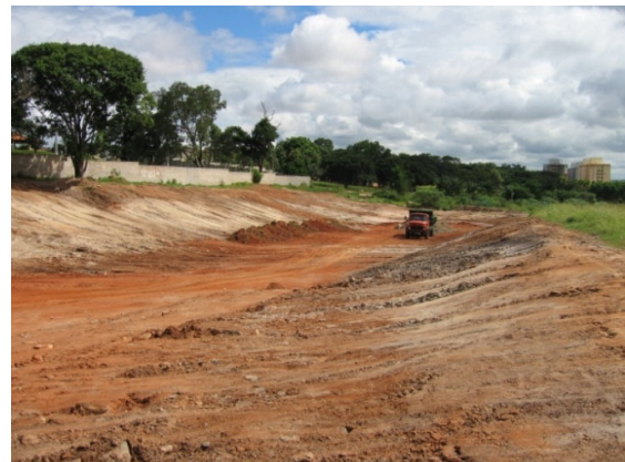
Figura 33. Afloramento de água aterrado em 2006
