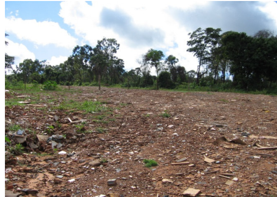
Figura 24. Remoção da camada superficial de solo da região aterrada em 2006
