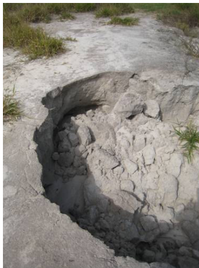
Figura 72. Solo escorregado no pé do talude no local de levantamento topográfico 2
