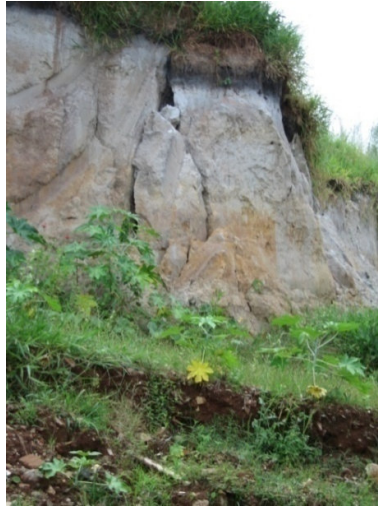
Figura 89. Escorregamento por alívio de pressão e solapamento da base
