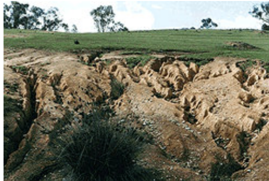
Figura 2. Vista geral de feições erosivas do tipo ravina (Ferreira, 2004)
