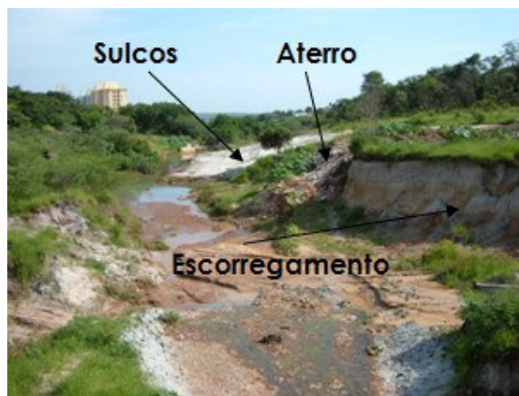
Figura 16. Vista geral do trecho erodido
