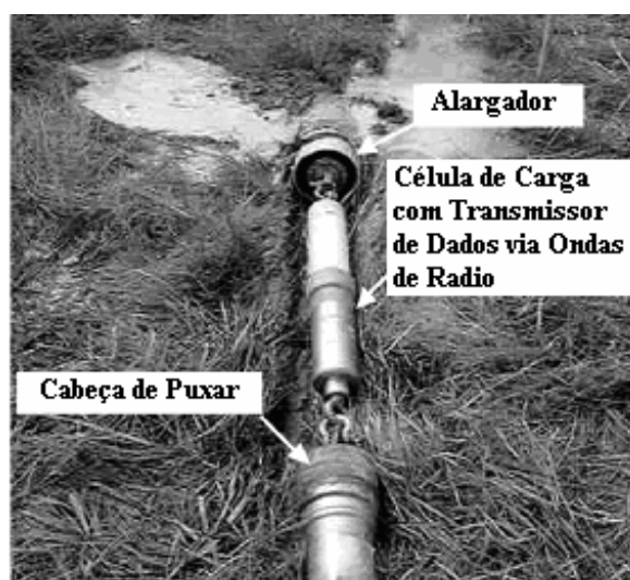
FIGURA 2. 27 – Célula de carga para monitorar os esforços no duto
