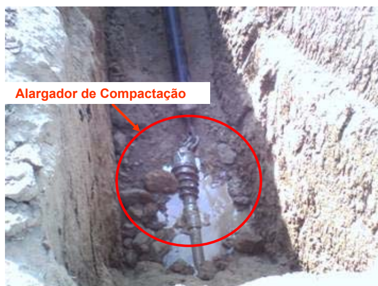
FIGURA 5. 2 – Detalhe do alargador de compactação selecionado
