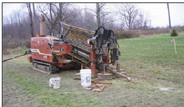
FIGURA 4. 2 – Perfuratriz Ditch Witch empregada na execução de rede de esgoto
