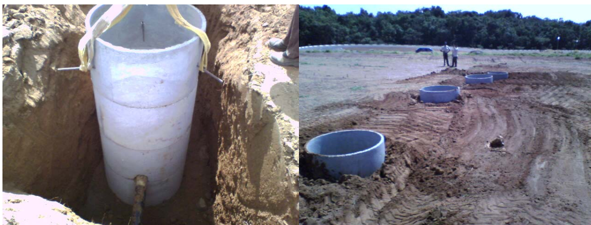
FIGURA 5. 10 – Poços de inspeção executados com aduelas de concreto para possibilitar leituras altimétricas
