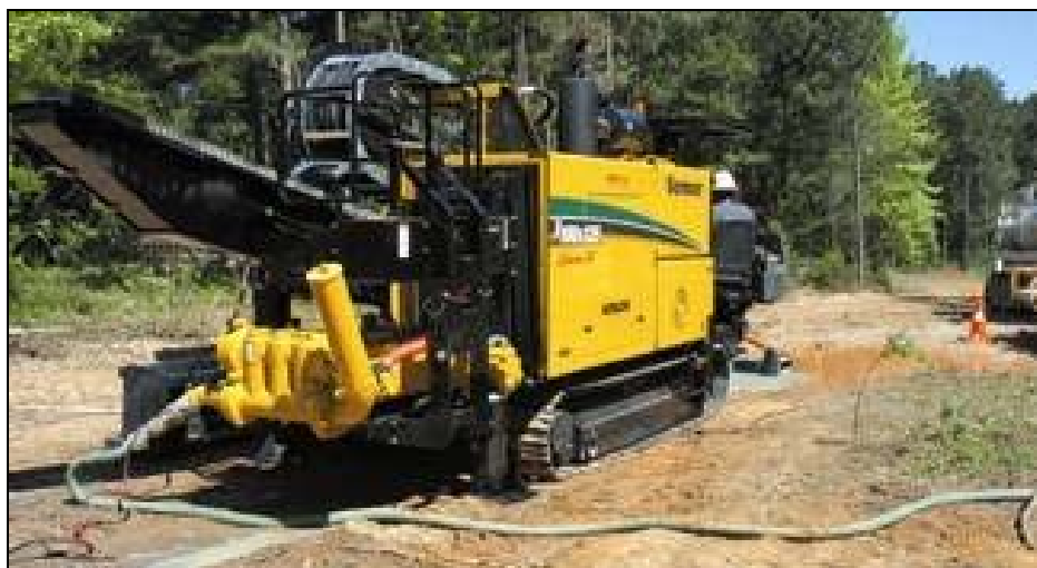
FIGURA 2. 6 – Perfuratriz de médio porte
