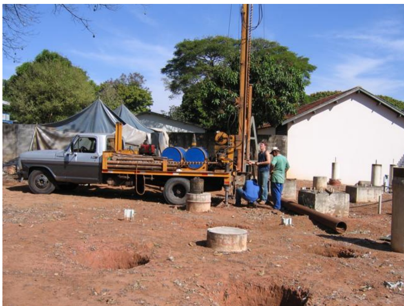
Figura 3.18 - Aparelhamento para realização de ensaios SPT mecanizados, adaptado para a cravação da sonda TDR.
