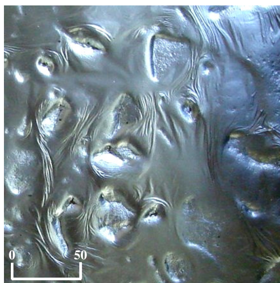
(b) Deformações na base compactada
