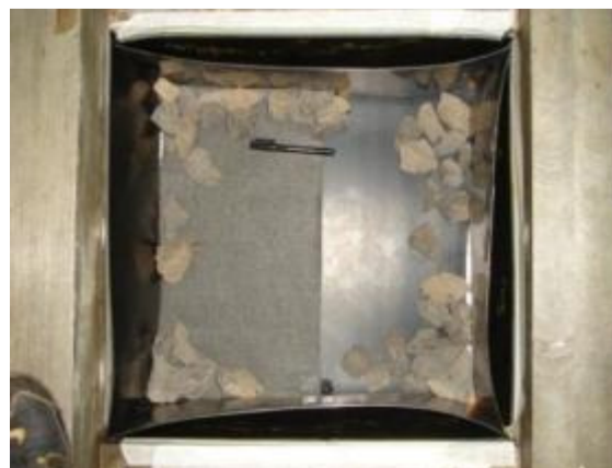
(b) Forragem das paredes com as folhas de geomembrana com graxa.
