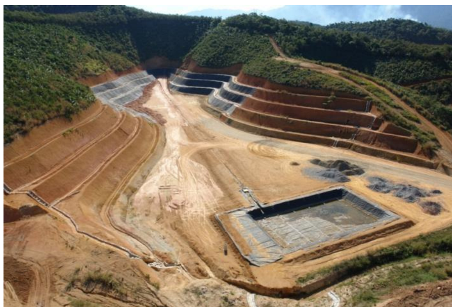
Figura 2.4 – Execução de barreiras de desvio de fluxo em aterro sanitário (ENGEORPS, 2006).
