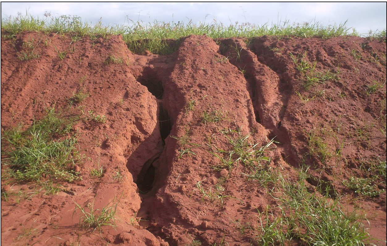
Figura 5.17: Solo residual da Formação Itaqueri (RI), com sulcos erosivos de médio porte.
