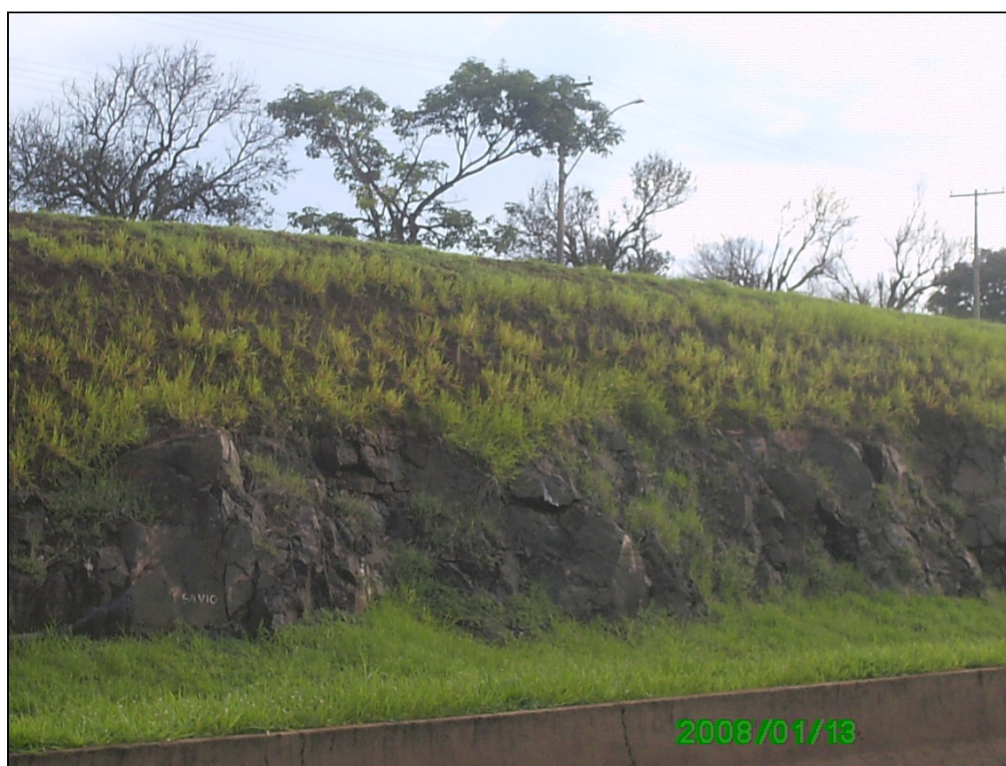
Figura 5.1: Talude na rodovia SP-225, exemplo de afloramento rochoso de basalto (A3).
