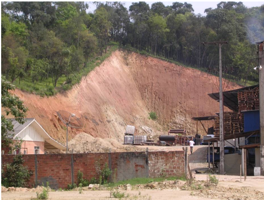
Figura 4.2 - Fábrica COM-KRAFT. Vista Geral do Talude.
