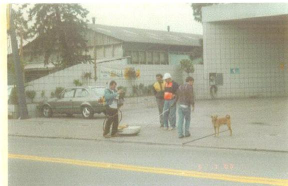
Foto 1- Fase I do levantamento dos dados com a antena blindada de 250MHz ao longo do perfil P-1
