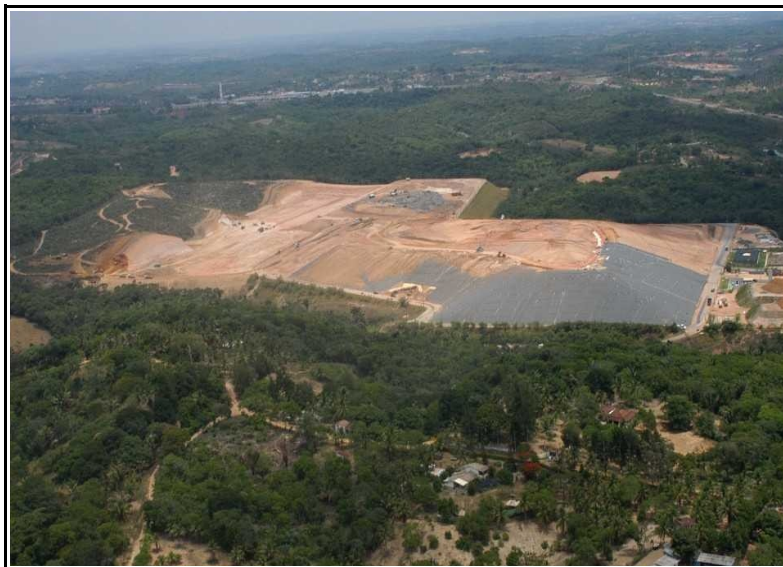
Figura 3.2. Fotografia aérea do Aterro Metropolitano Centro.
