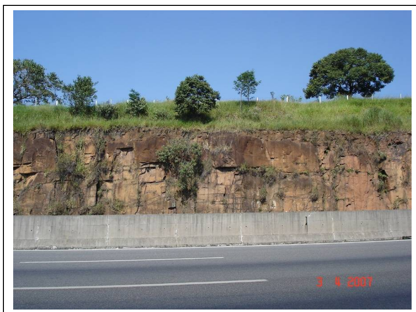
Figura 25: Rocha Alterada Dura R2 Ba, Pto 9/ Seção 9.
