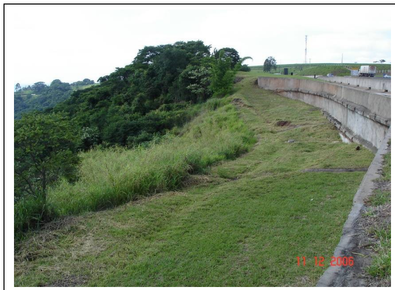
Figura 34: Cortina atirantada localizada ao lado do redutor de energia – Pto 8.
