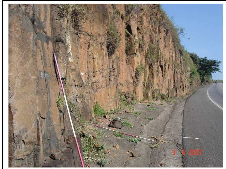
Figura 30: Queda de blocos decimétricos (em vermelho) de Rocha alterada dura (R2 Ba) da Formação Serra Geral km 196 +300, Pto 10/ seção 10.
