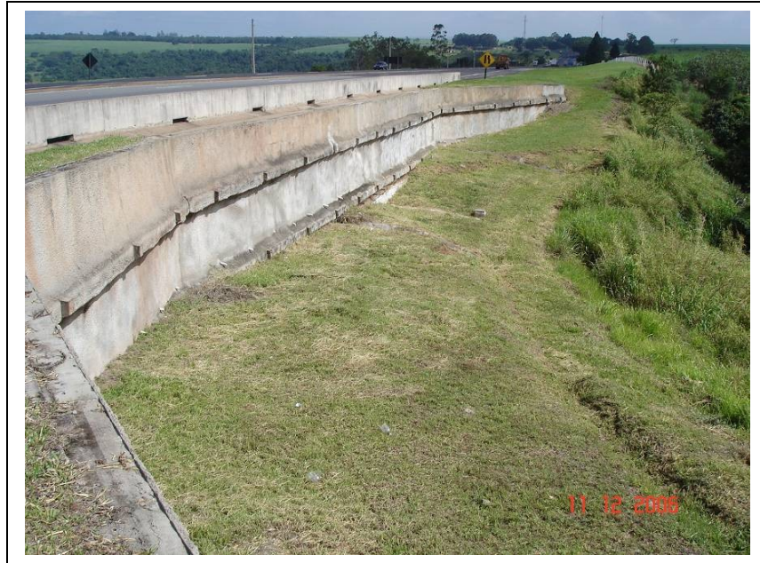
Figura 35: Obra de contenção – Cortina atirantada
