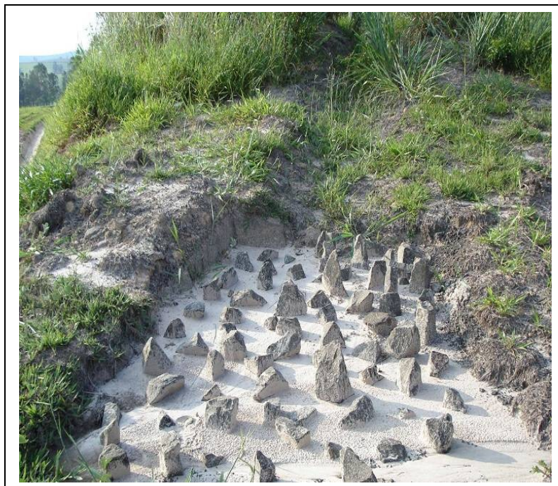
Figura 32: Redutor de Energia Pto 21/ seção 21.
