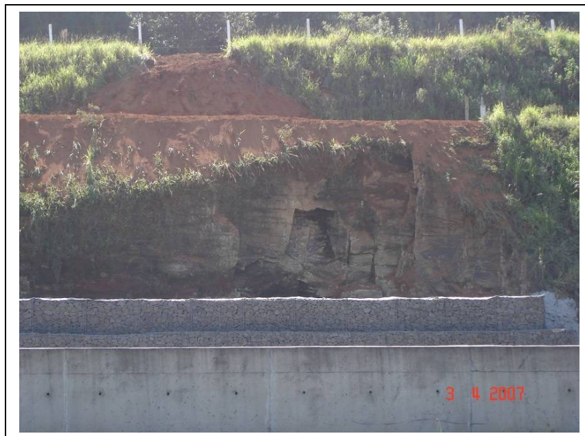
Figura 36: Escorregamento condicionado por estruturas (a) antes da realização da obra de contenção e (b) com o gabião.
