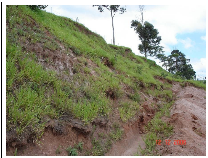
Figura 29: Escorregamento causado por evolução da erosão associada por sua vez a obras de drenagem mal estruturadas.
