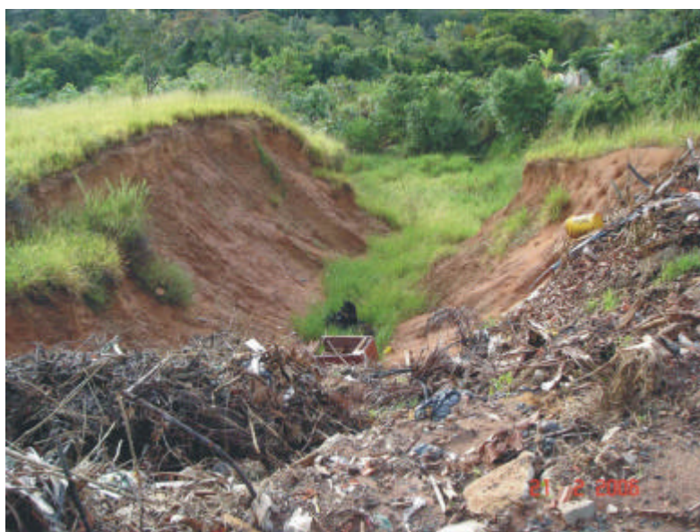
Figura 6.5 - Ravina na área urbana, onde é jogado entulho e, eventualmente, lixo doméstico (Ponto 23).
