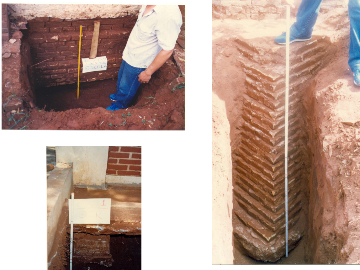
Fig. 8.2. Exemplos de poços abertos para inspeção das fundações.
