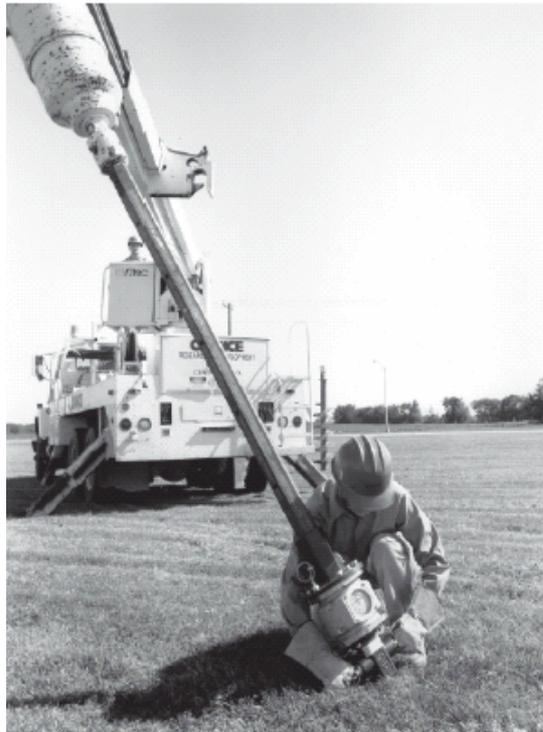
Figura 2.13 – Instalação de estaca metálica helicoidal inclinada (A. B. Chance Co., 2004)
