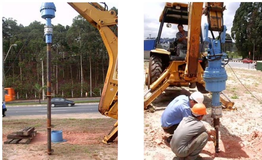
Figura 4.3 - Instalação de estaca metálica helicoidal em Contagem
