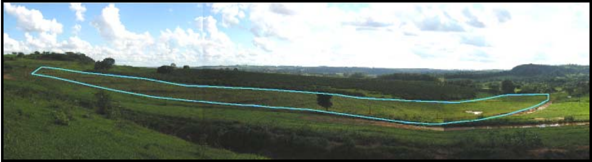
Figura 18: Vista atual da área de estudo, a linha azul indica a antiga cava de resíduos.
