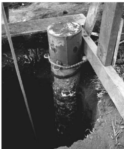
**Figura 4.16 - Poço de inspeção PE4**
