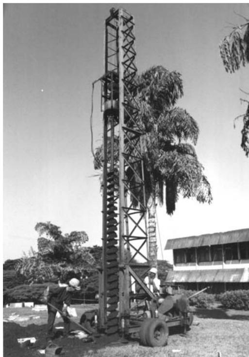
**Figura 2.26 - Estacas escavadas com trado mecânico**
