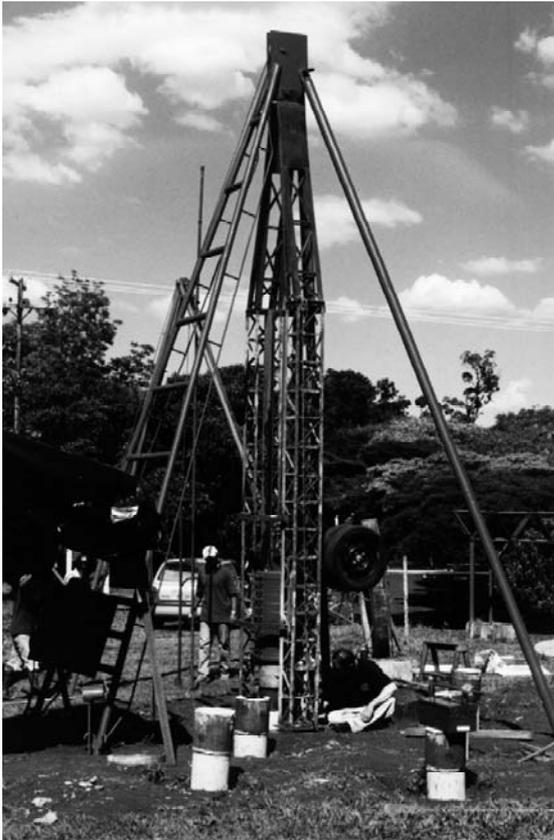
**Figura 4.7 - Vista geral do bate-estacas (VESSARO et al., 2004)**
