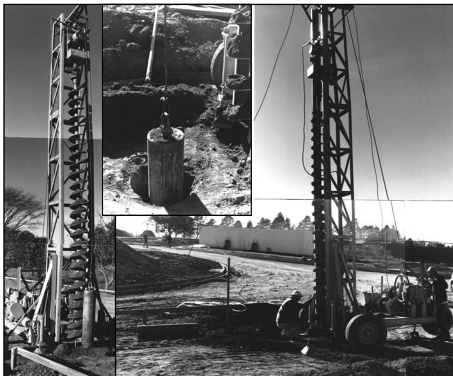
Figura 2.41 - Execução de apiloamento da ponta
