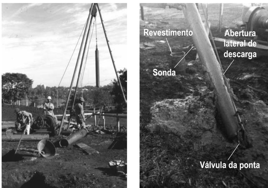
**Figura 2.24 - Estacas Strauss – Vista geral e detalhe**
