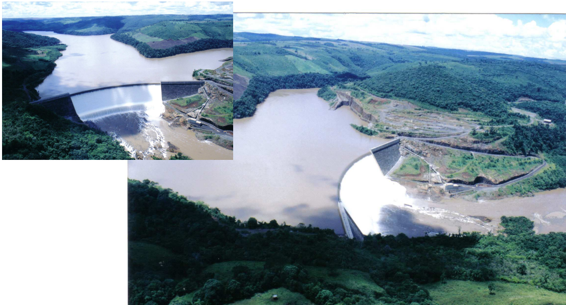
Figura 3.5. Vista aérea da barragem da Derivação do Rio Jordão
