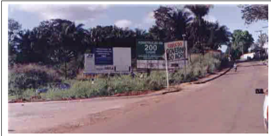
Figura 34 – Paisagem típica da UBC 4- Interflúvios Tabulares com retirada de vegetação e decapeamento de solos para construção imobiliária.
