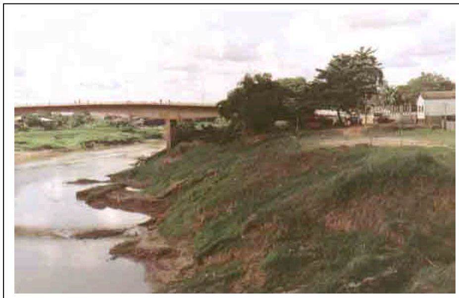
Figura 30 e 31 - Ocupação em área marginais do Rio Acre - Área urbana do Município de Rio Branco/AC. Paisagem típica de UBC 1
