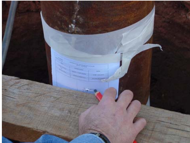
Figura 4.9 – Medição da nega
