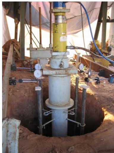
Figura 4.14 – Montagem da prova de carga estática
