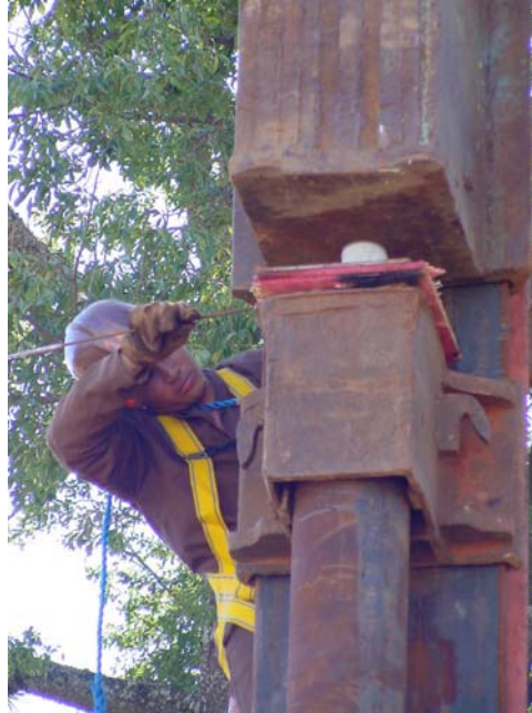
Figura 4.11 – Utilização do gabarito de PVC
