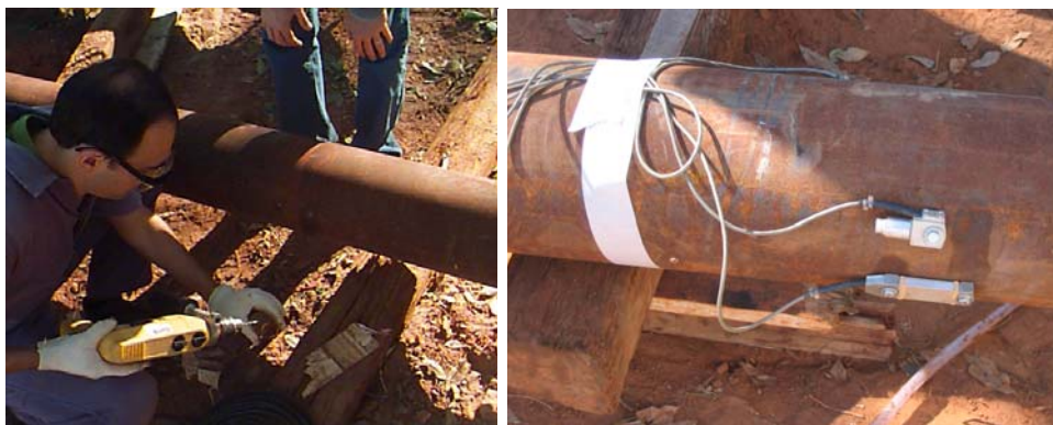
Figura 4.4 – Instalação dos sensores
