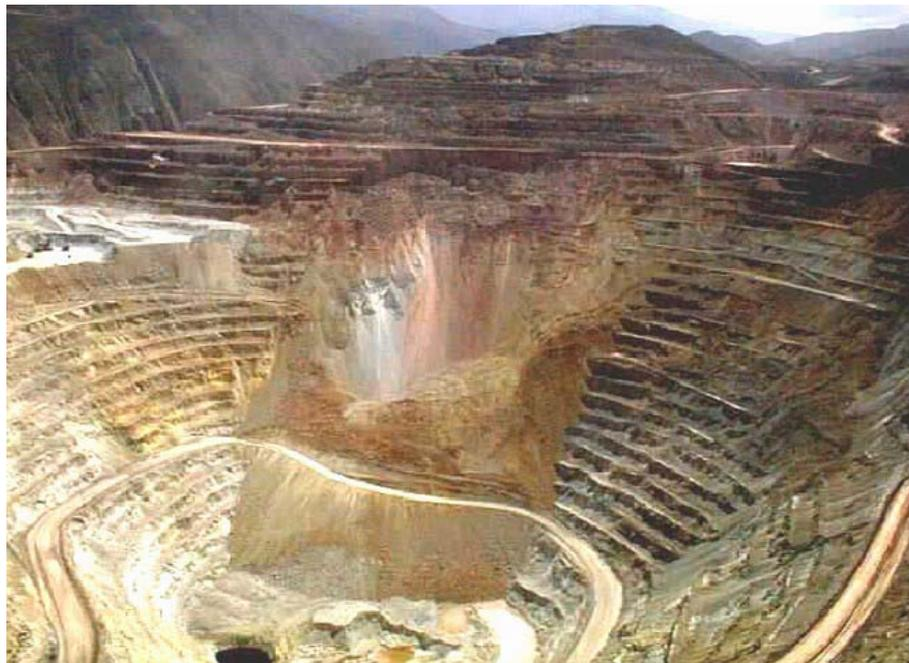
FIGURA 2.7 Exemplo de ruptura em taludes altos de mineração a céu aberto (HOEK *et al.*, 2000b).
