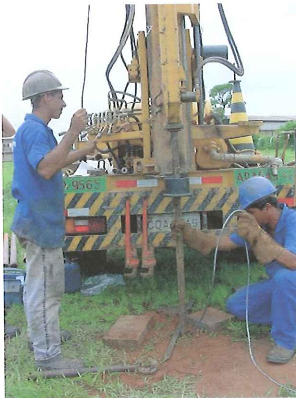
**Figura 4.13 – Execução da sondagem SPT**
