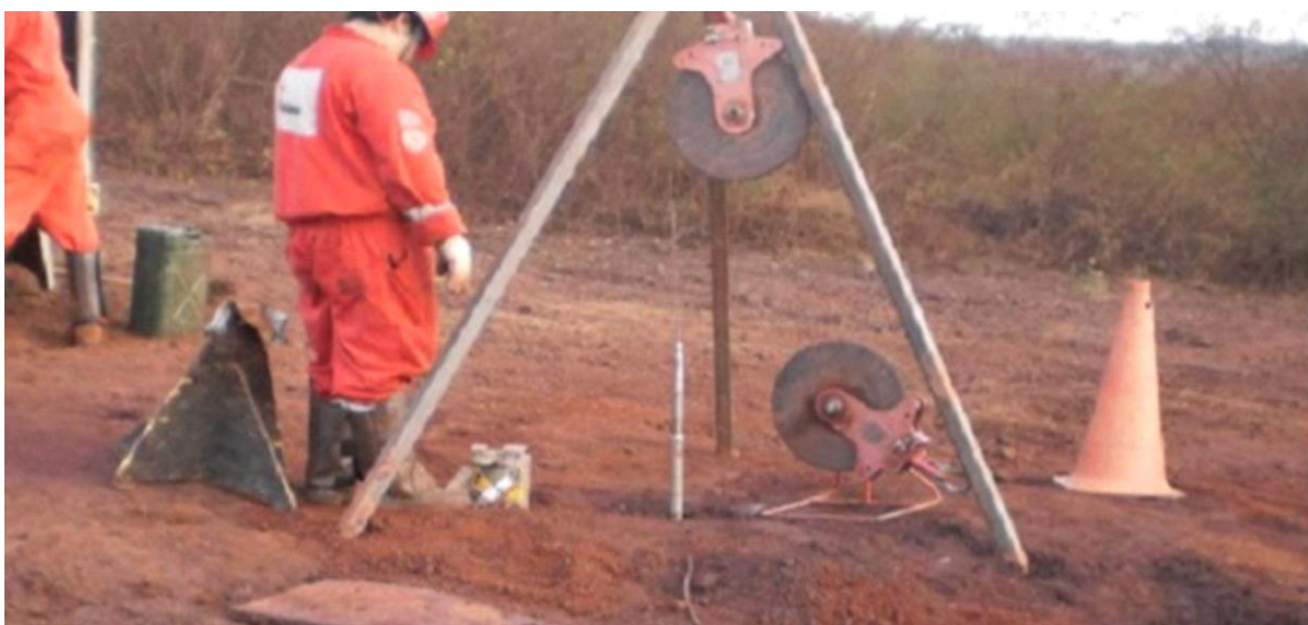
Figura 3.17 – Perfilagem Geofísica em furos de sondagem.
