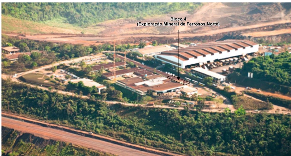
Figura 1.2 – Escritório Central, Sistema Norte, mina de N4.
