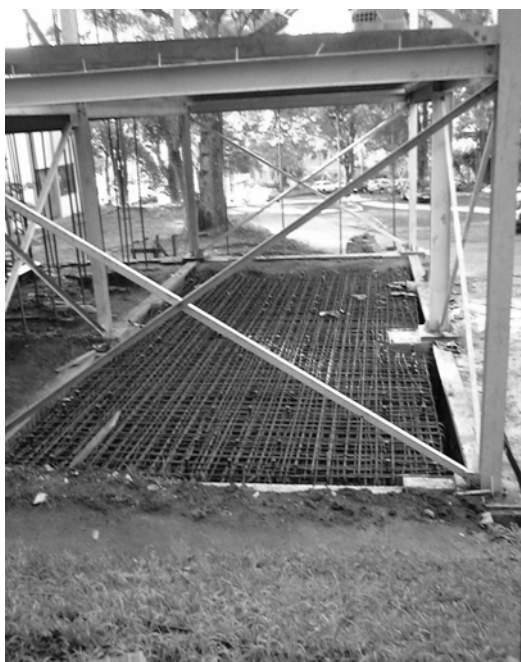
Figura 3.19 – Vista geral da construção e da disposição das armaduras na laje de reação.
