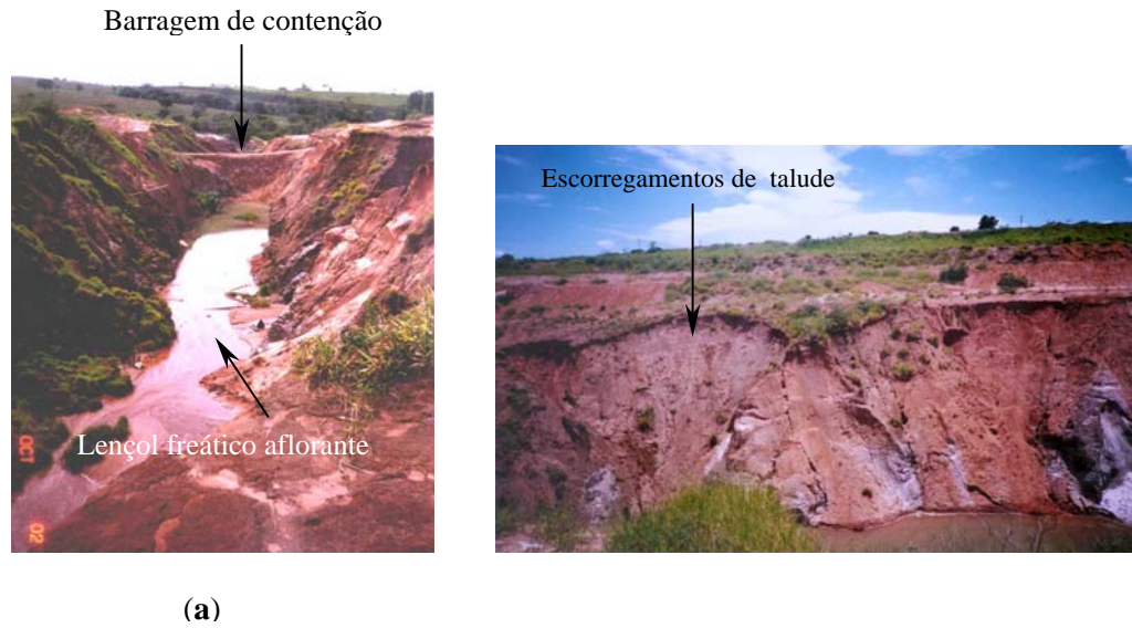
FIGURA 45 - (a) Feição erosiva B apresentando lençol freático aflorante e a barragem de terra utilizada como medida de controle; (b) Escorregamentos de taludes provocado no último período chuvoso na região (jan/2003).
