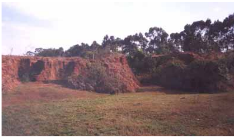
FIGURA 31 – Material retrabalhado situado na fazenda São Sebastião (Ponto 49).
