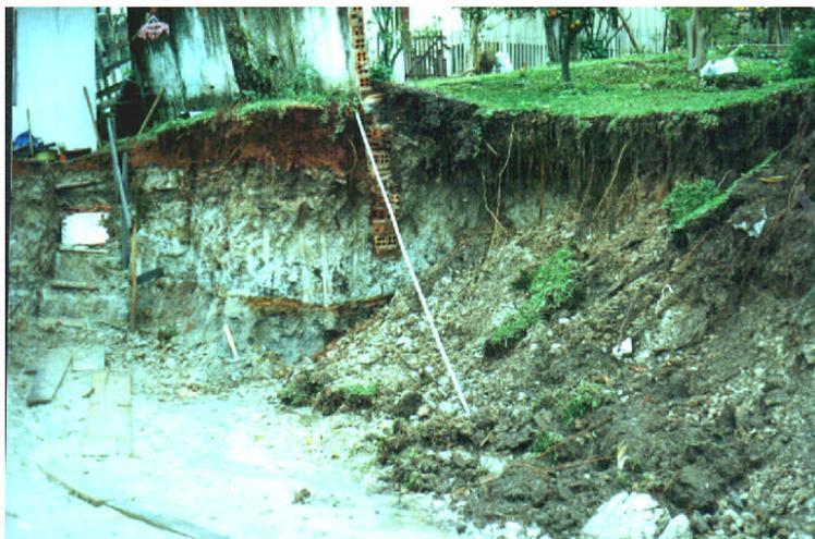
**FIGURA 10.4 - Corte em argila cinza da Formação Guabirota com 2m de altura - o solo se desfez em torrões centimétricos – Bairro Guabirota (ponto 2).**
