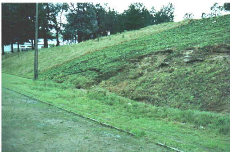
**FIGURA 10.5 - Talude em argila fraturada da Formação Guabirota, com inclinação de 35 graus apresentando diversas rupturas - Centro Politécnico - UFPR (ponto 3)**
