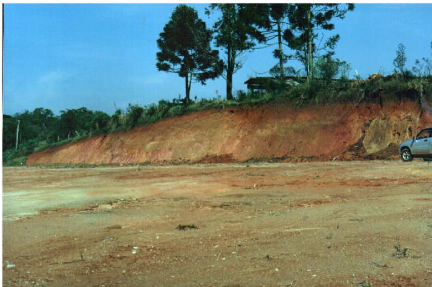
**FIGURA 10.13– Corte em solo residual de migmatito.**
