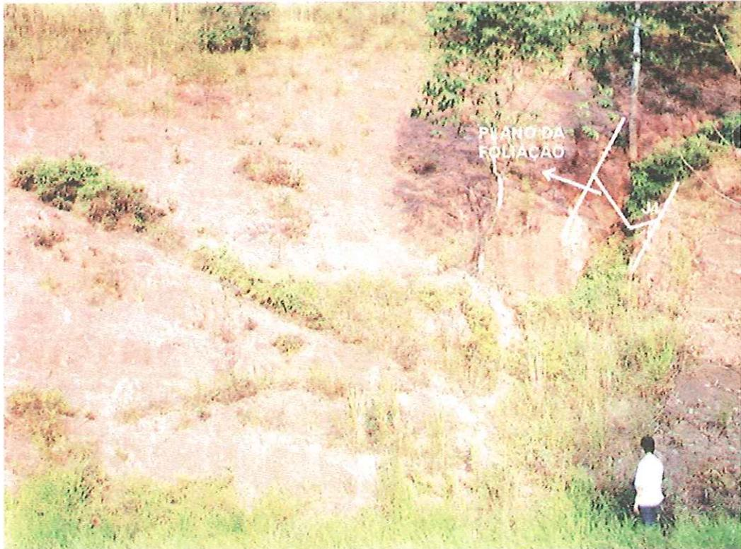
FOTO 6.12 – Escorregamento em cunha no talude 07, formado pela intersecção de J4 (354/70) com a foliação.
