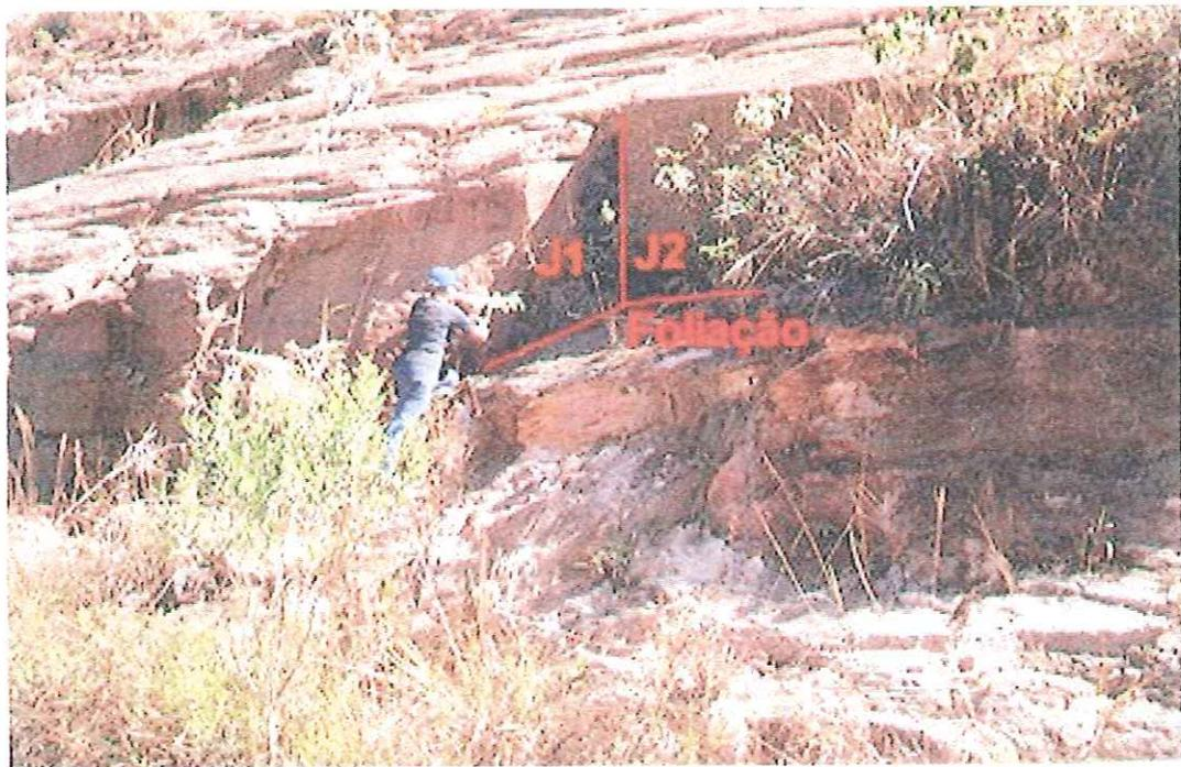
FOTO 6.5 – Escorregamento planar no talude 19. A junta J2 (325/82) atua como fenda de tração, e a junta J1 (232/71) como plano lateral de desconfinamento.
