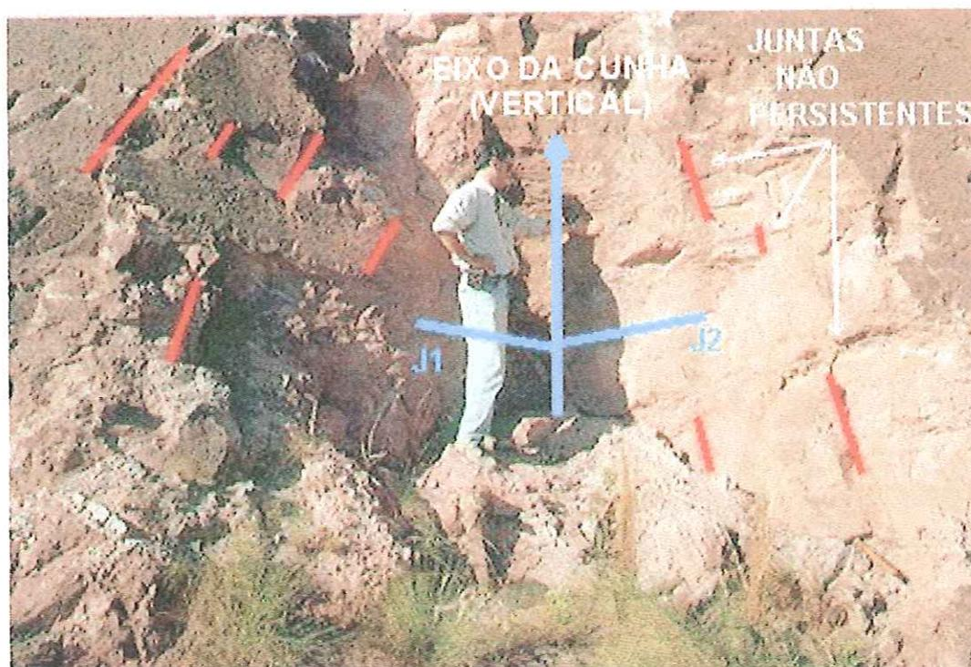
FOTO 6.13 – Tombamento de blocos no talude 03. Em vermelho estão destacados os traços dos planos verticais das juntas J1(111/89) e J2 (002/86), mostrando que não são persistentes. Em azul destaca-se o vértice vertical dos blocos, que possuem dimensões aproximadas de 0.3 m de altura, por 0.5 m de comprimento.
