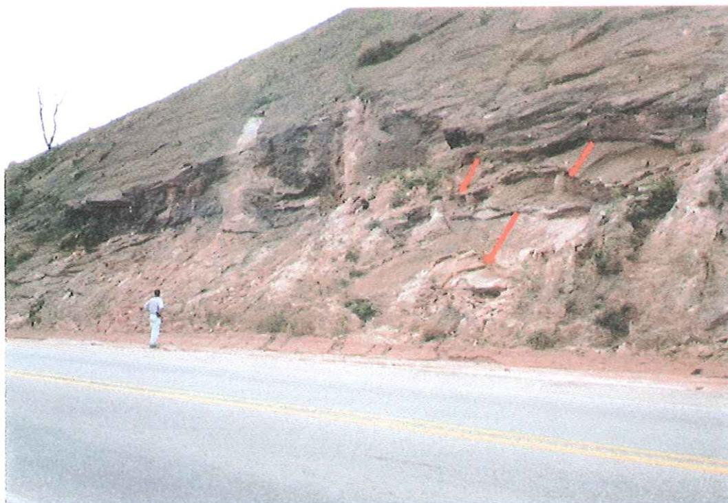
FOTO 6.8 – Talude 18. Plano de foliação mergulhando em direção à rodovia (indicado pelas setas vermelhas), induzindo escorregamento do tipo planar.
