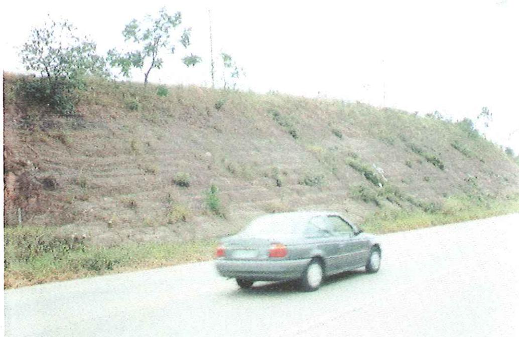
FOTO 6.22 – Vista do talude 20, sem rupturas e feições erosivas.
