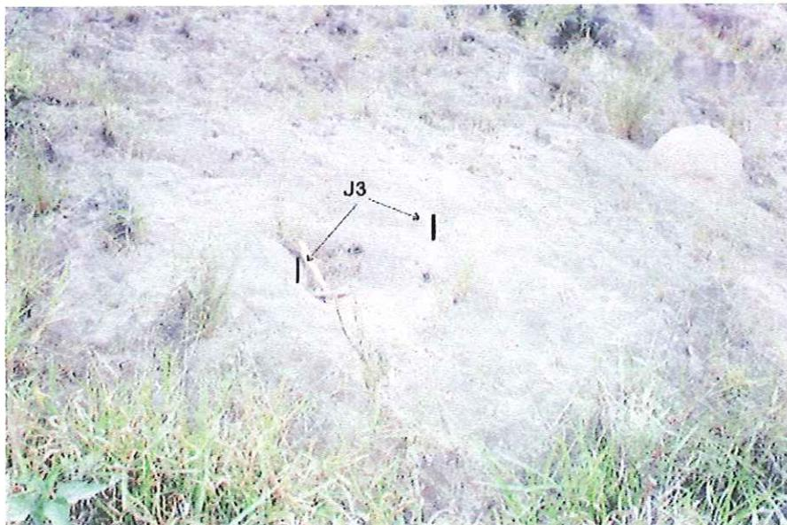
FOTO 6.23 – Detalhe do talude 20, mostrando o comportamento da família J3 (059/76).
