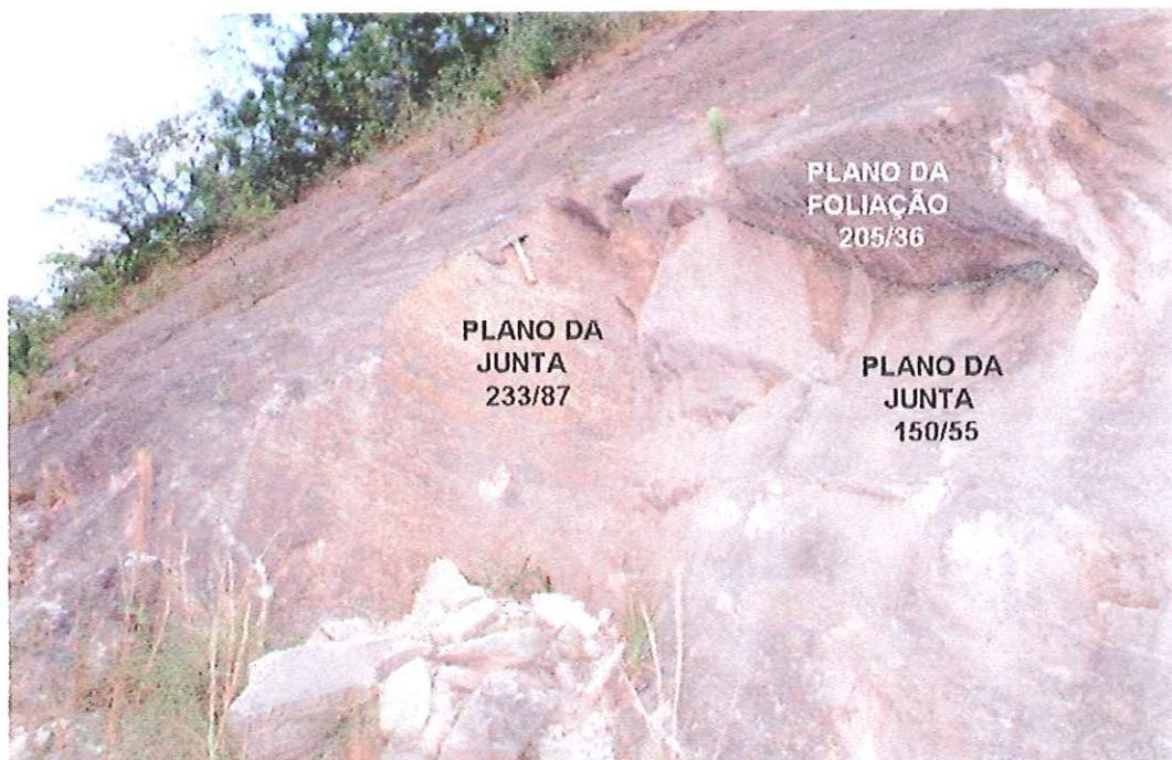
FOTO 6.2 - Detalhe da Foto 6.1, mostrando em detalhe os planos que condicionam a ruptura planar no talude 09.
