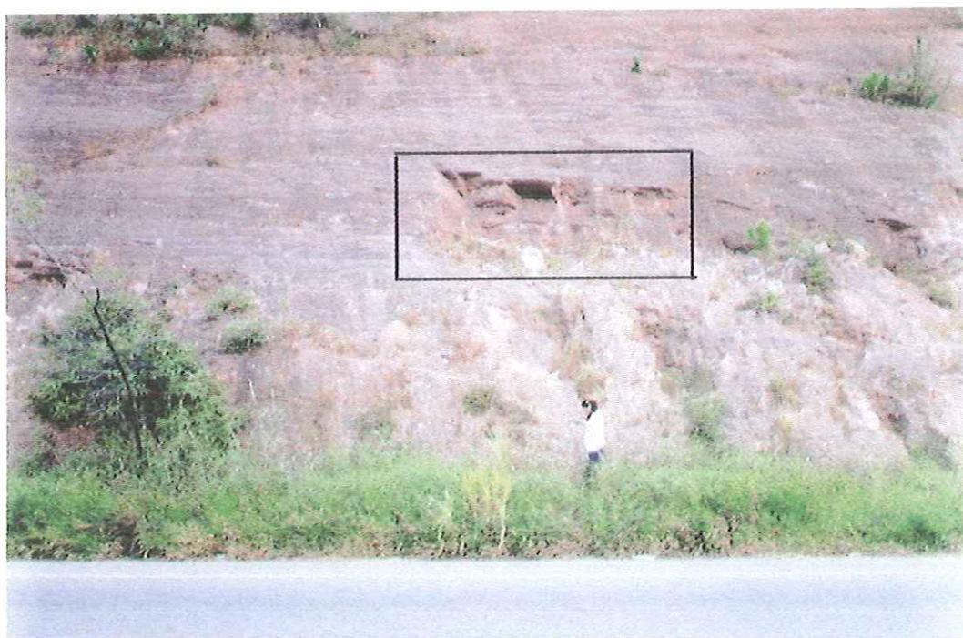
FOTO 6.1 - Ruptura planar no talude 09. O retângulo destaca os planos que condicionam o escorregamento, que podem ser melhor visualizados na Foto 6.2.
