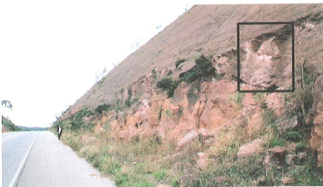
FOTO 6.17 – Descalçamento de blocos seguido de colapso no talude 18. O retângulo destacado está ampliado na Foto 6.18, detalhando as estruturas que causam a instabilidade.
