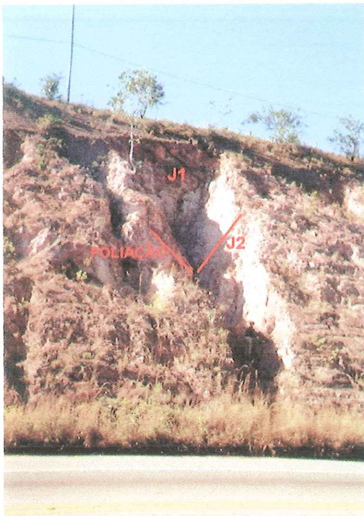
FOTO 6.11 – Cunha erosiva no talude 05 (face SE do corte).
