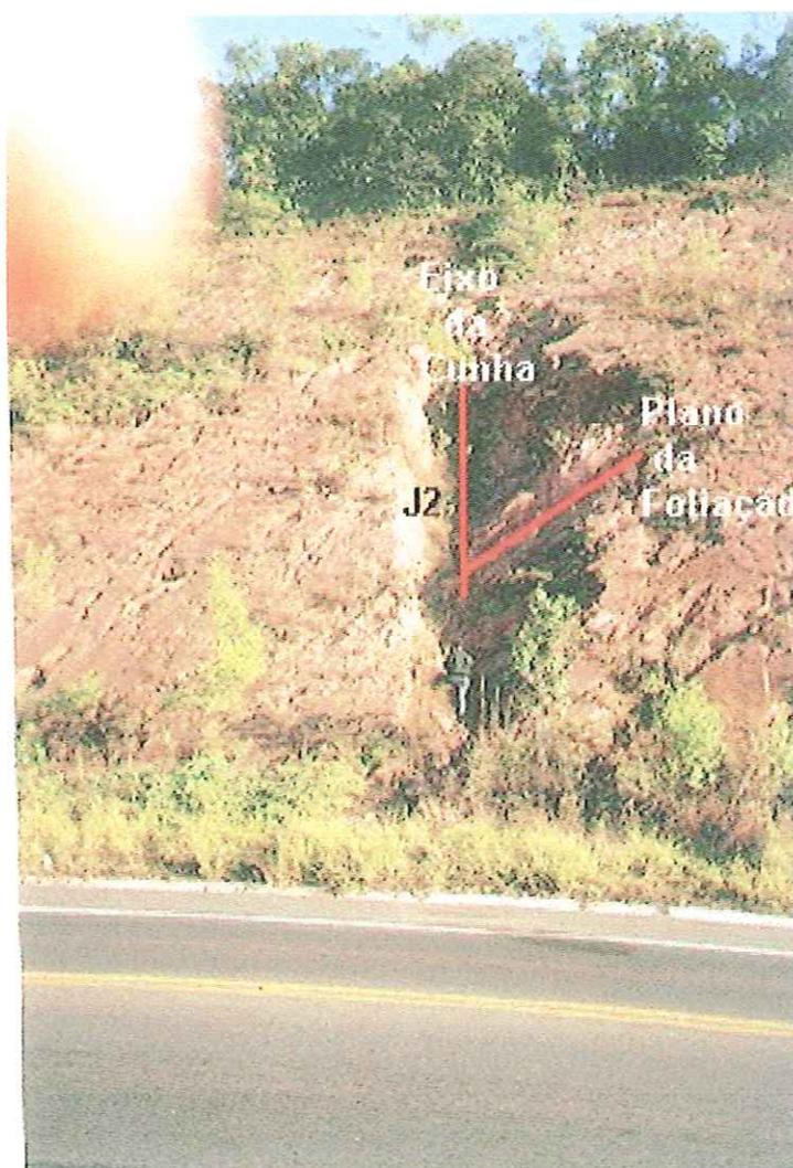
FOTO 6.9 – Cunha erosiva no talude 01.
