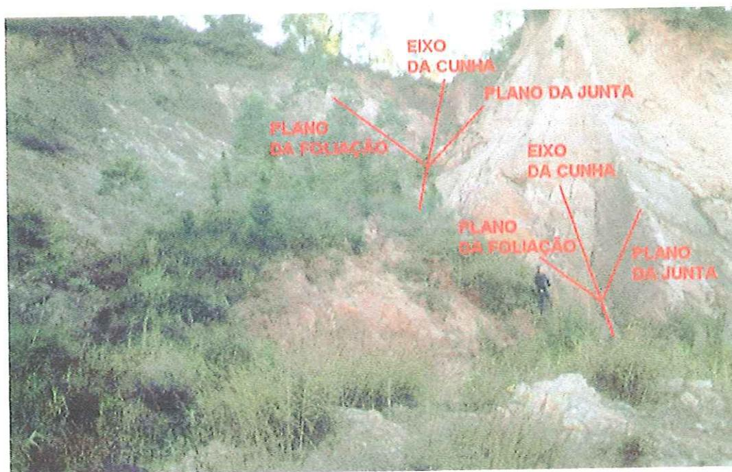
FOTO 5.3 - Talude localizado na cidade de Campo Limpo Paulista (ponto 35), onde se observam escorregamentos em cunha definidos pela intersecção de uma família de juntas (312/65) com o plano da foliação (187/58), com eixo apresentando atitude média de 248/45.
