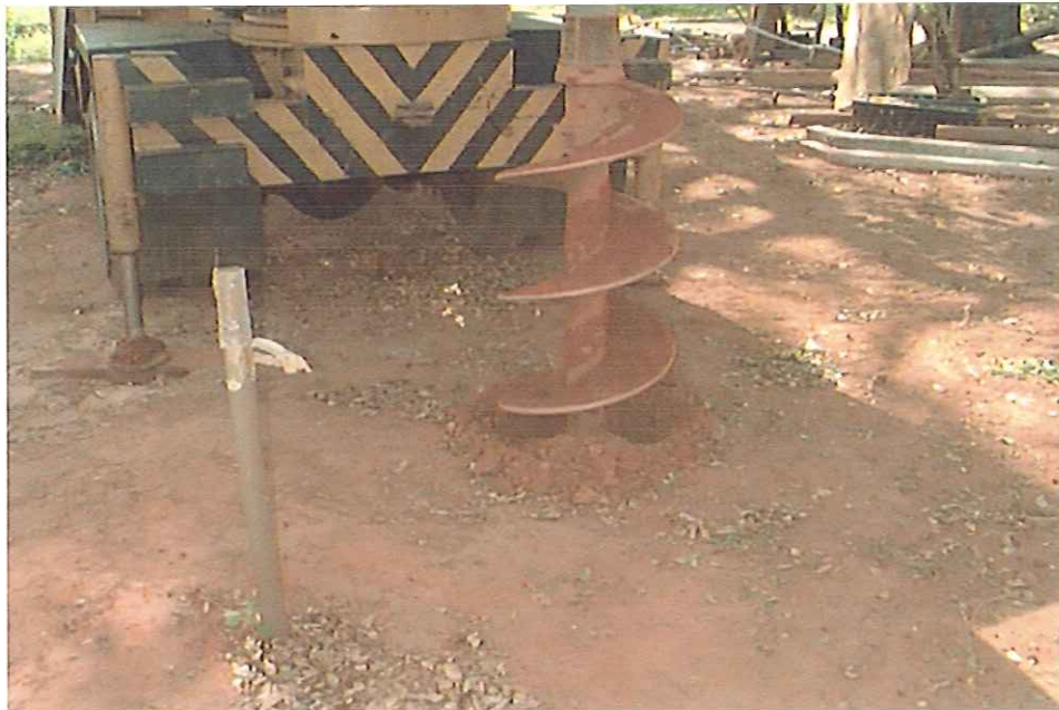
FIGURA 4.4: Escavação Mecanizada do Fuste.
