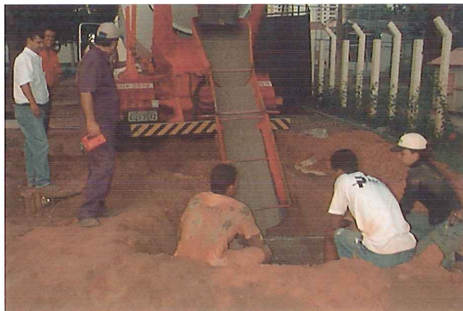
FIGURA 4.7: Concretagem da Base, no Tubulão TE 1.
