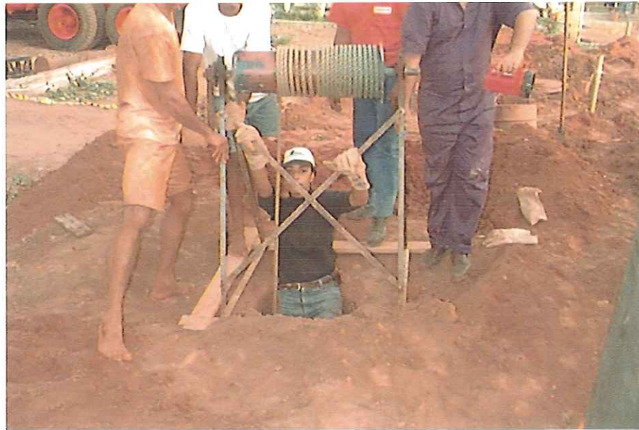
FIGURA 4.6: Operação de Descida no Poço do Tubulão, para a Liberação da Base.
