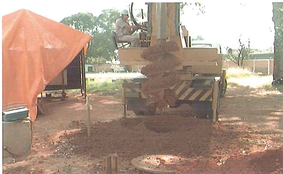
FIGURA 4.5: Escavação Mecanizada do Fuste, com a Retirada do Material Escavado.
