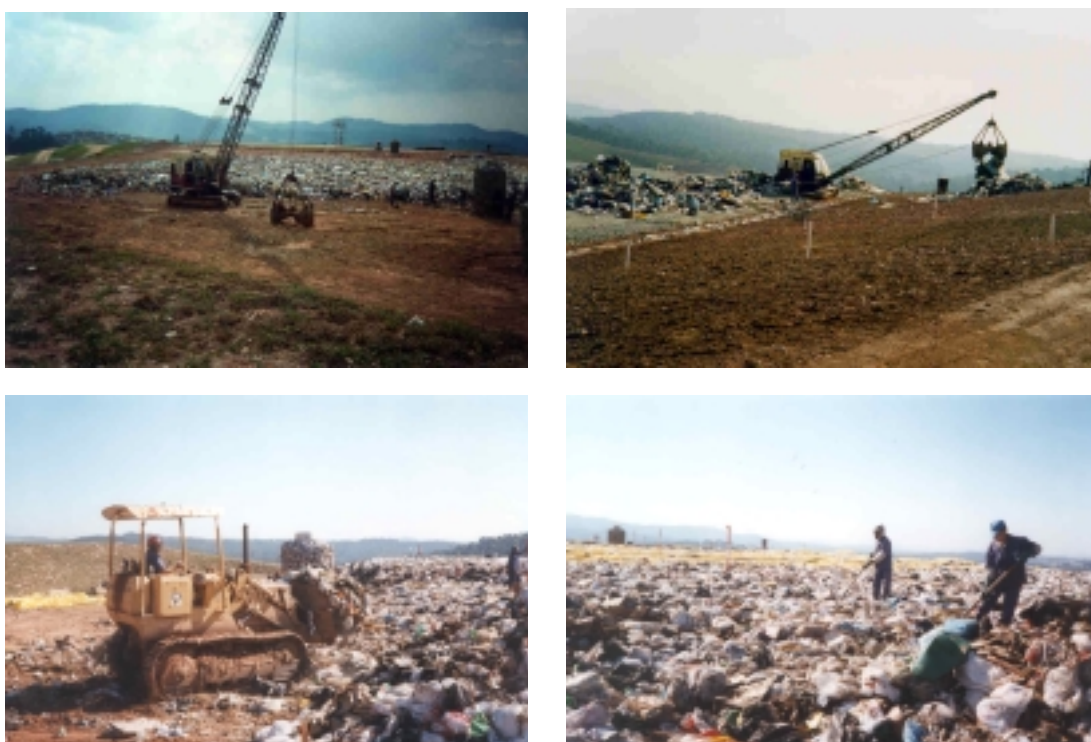
Figura 3.5.1 – Lançamento dos resíduos nas praças de trabalho em plano horizontal e inclinado.
