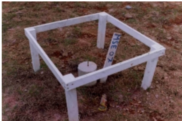
Figura 3.2.9 - Aterro experimental – Marco superficial instalado.
