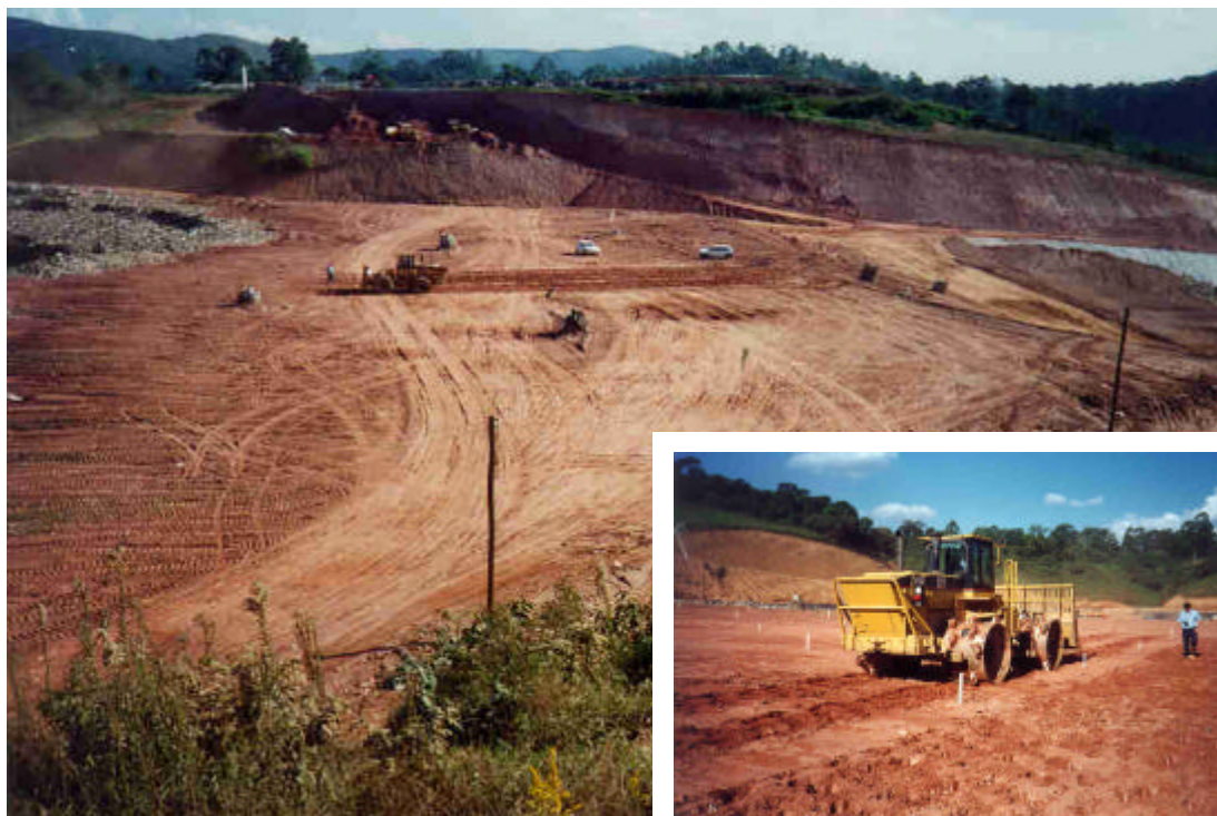
Figura 3.4.2 – Treinamento operacional previamente à execução do aterro.
