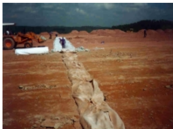
Figura 3.2.6 - Detalhes do sistema de drenagem do aterro experimental.
