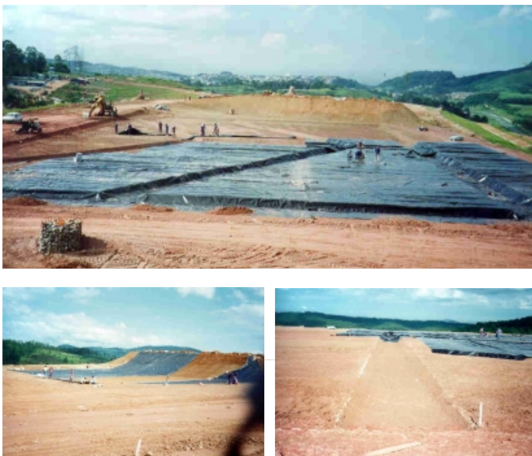
Figura 3.2.4 - Detalhes e vista do tratamento de fundação do aterro experimental.
