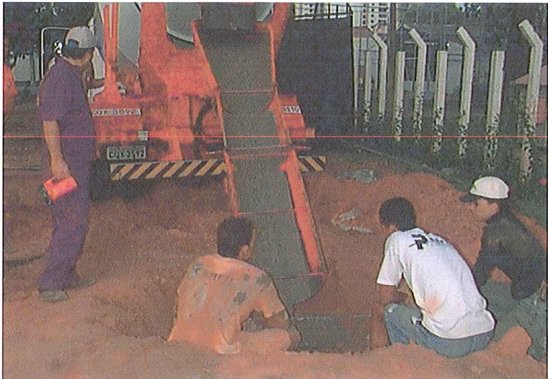
FIGURA 4.5 - Detalhe da Concretagem dos Tubulões
