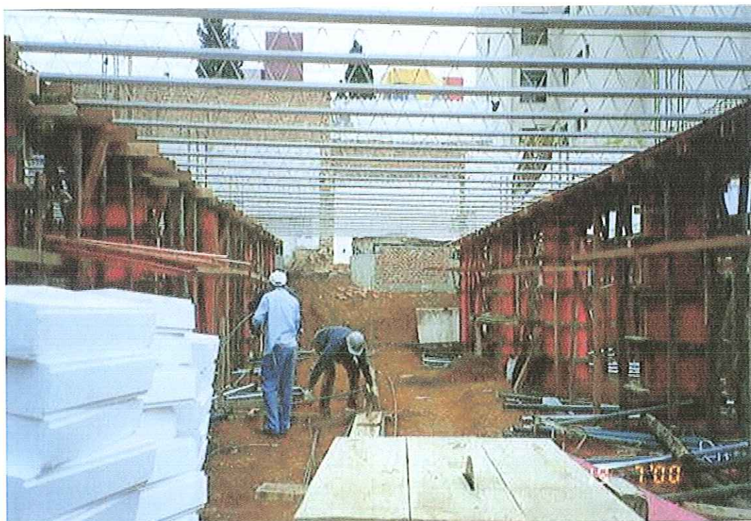
FIGURA 2.38 : Visão parcial das vigas pré-moldadas
