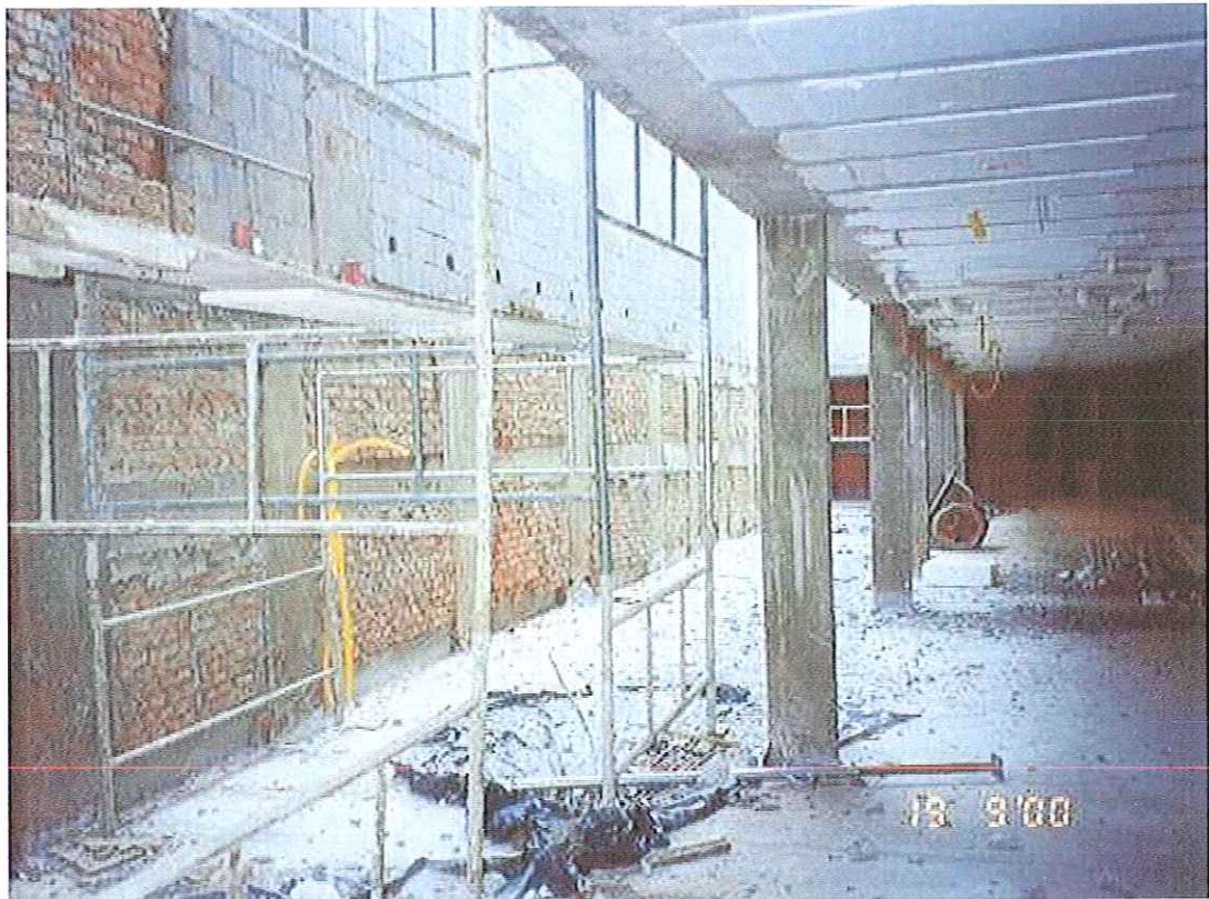
FIGURA 2.46 : Detalhe do muro de arrimo executado
