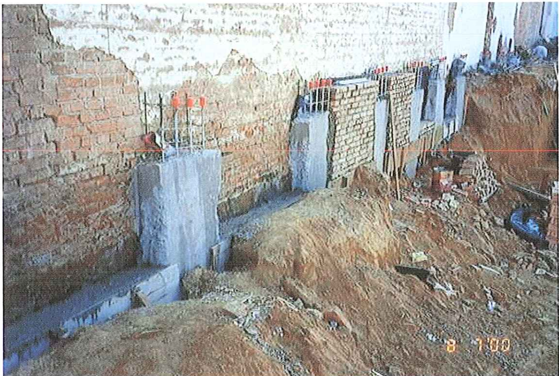
FIGURA 2.37 : Visão parcial da viga de travamento
