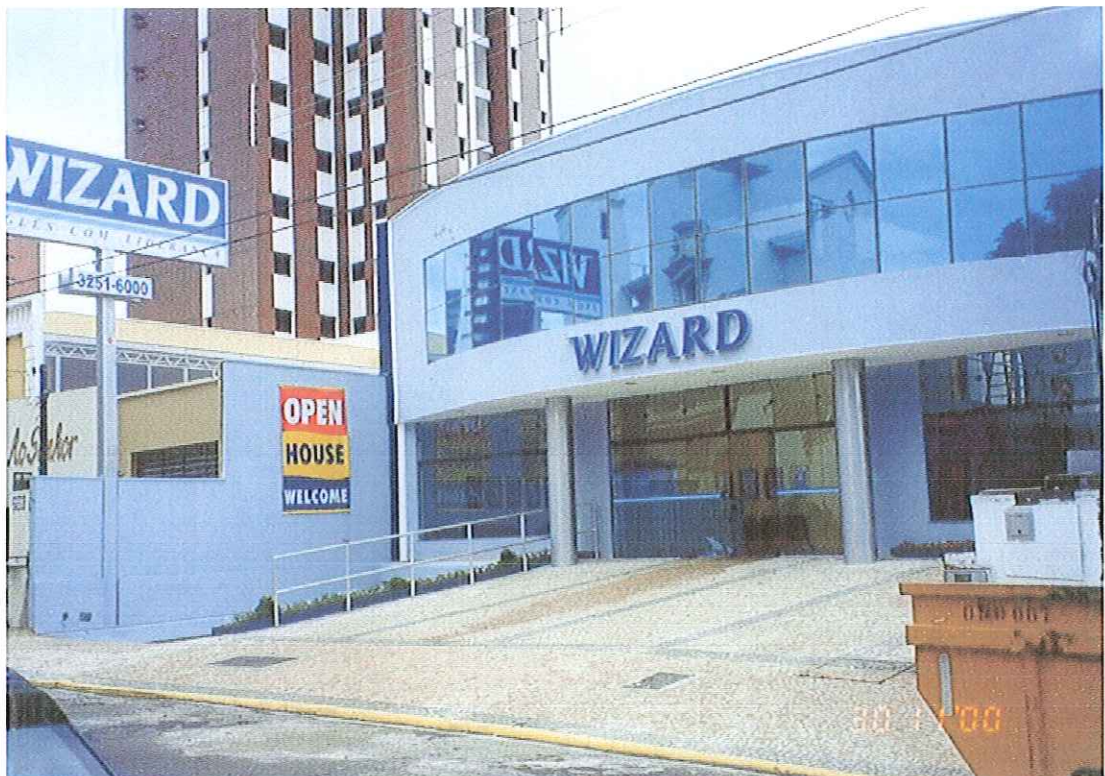
FIGURA 2.49 : Vista da fachada Final da Obra
