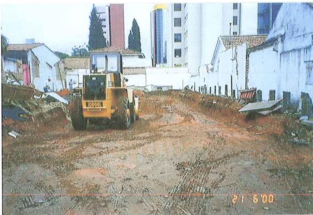
FIGURA 2.27 : Início da Escavação do Sub-Solo
