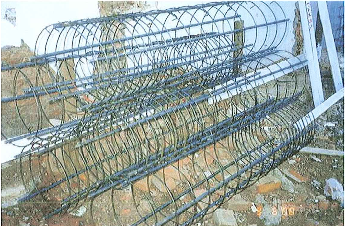
FIGURA 2.17 : Detalhe de ferragem dos tubulões centrais
