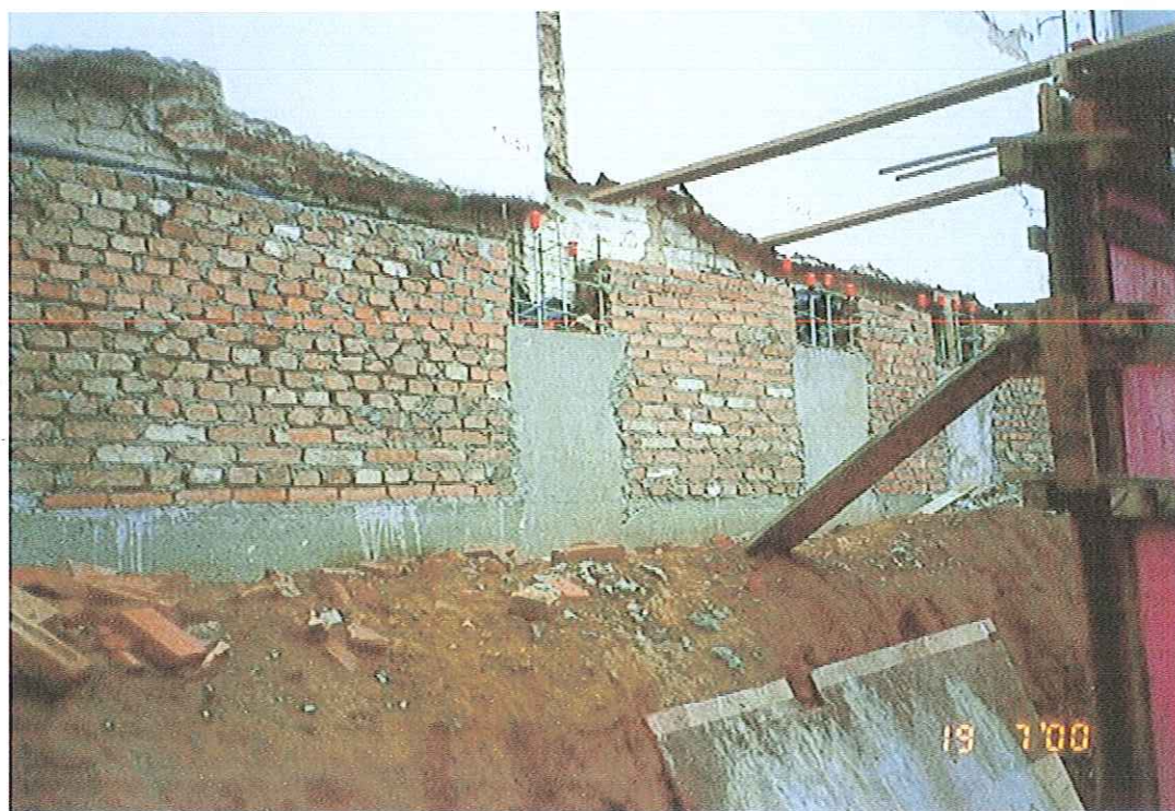
FIGURA 2.44 : Detalhe da alvenaria da divisa
