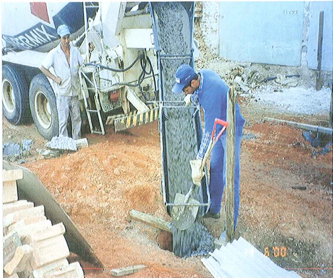
FIGURA 2.24 : Concretagem de um tubulão central
