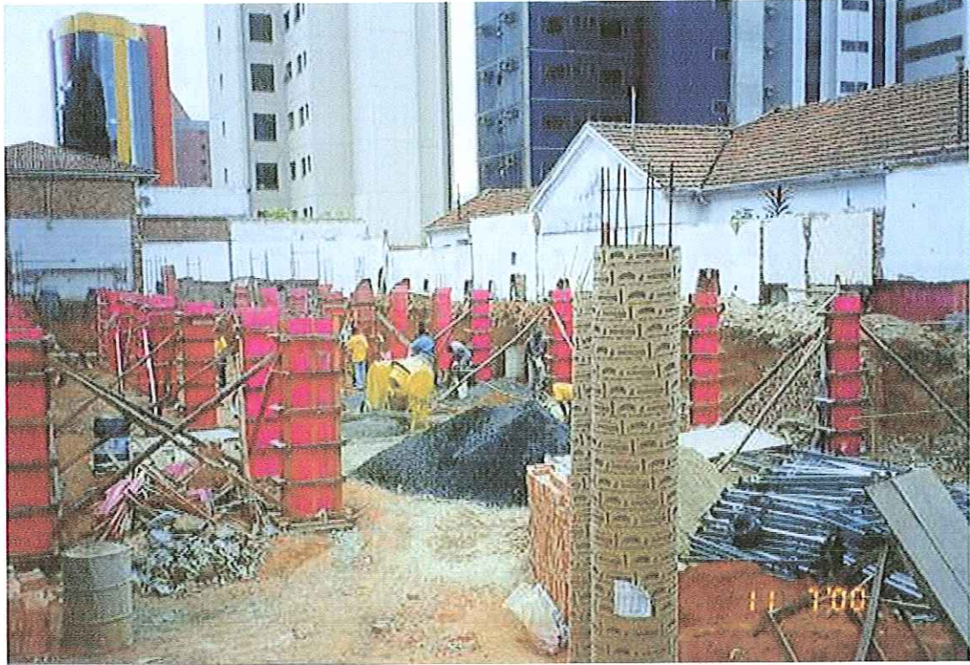
FIGURA 2.35 : Vista Geral das Formas dos Pilares Principais
