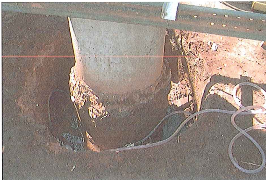
FIGURA 5.14 : Tubulão 2 - Ensaio Pré-Inundado.
