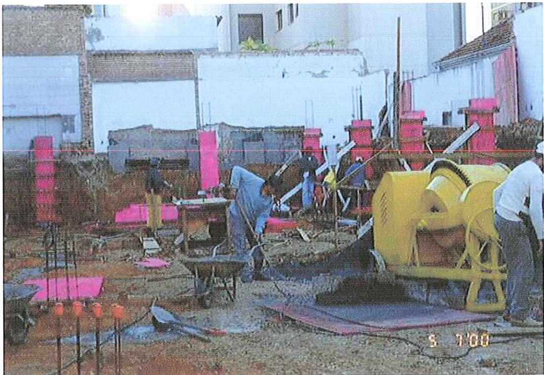
FIGURA 2.34 : Fôrmas dos pilares principais
