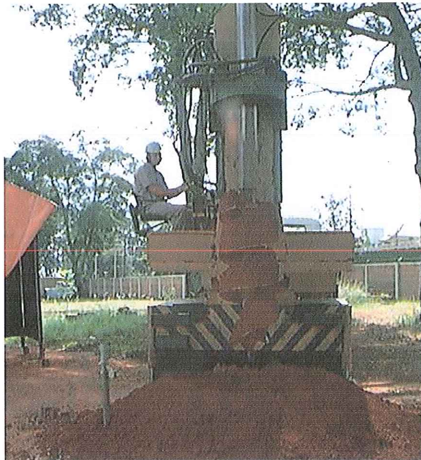
FIGURA 4.3: Detalhe da Perfuratriz Mecanizada .
