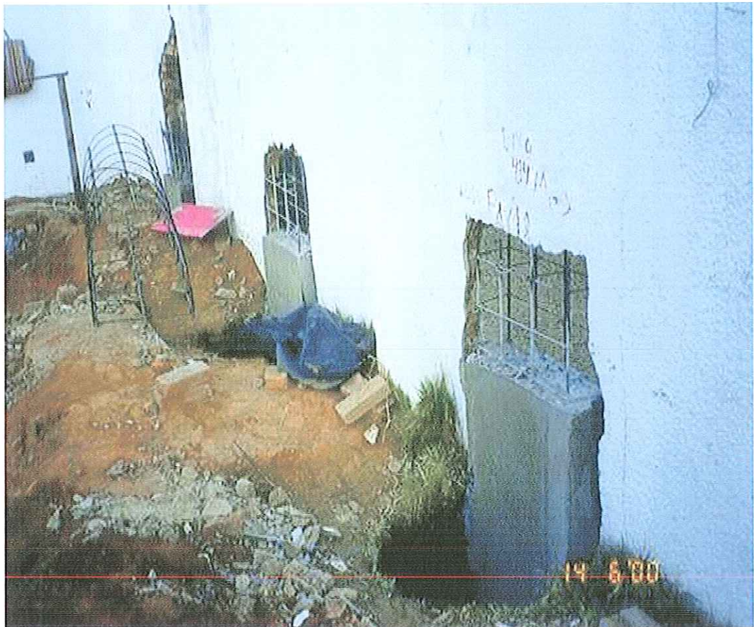
FIGURA 2.25 : Pilares do sub – solo concretados
