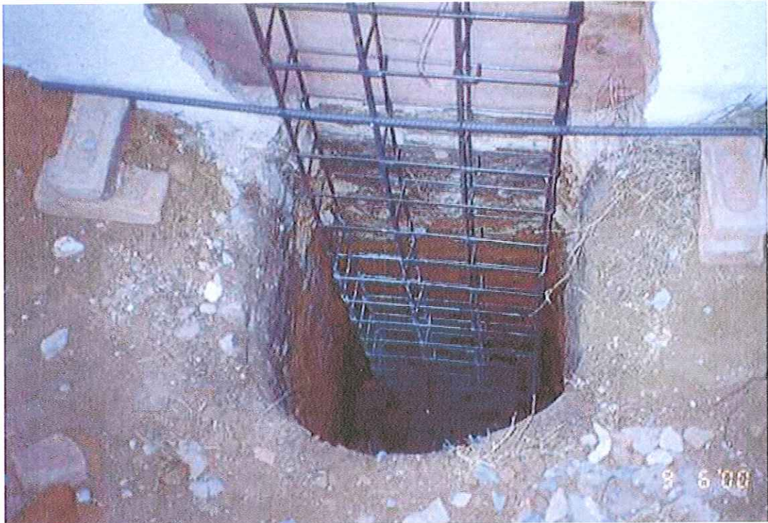
FIGURA 2.21 : Vista frontal do tubulão de divisa com ferragem do pilar
