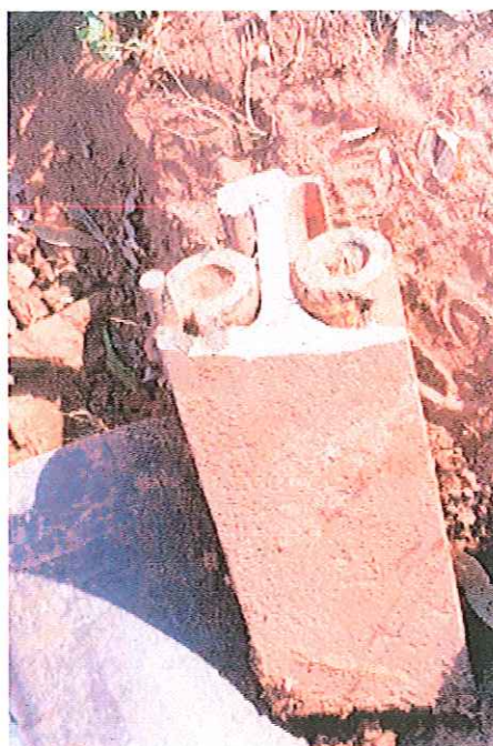
FIGURA 5.12 : Detalhe da ruptura do trilho TR-68.
