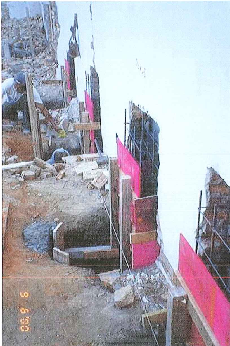
FIGURA 2.23 : Vista de forma dos pilares dentro do tubulão
