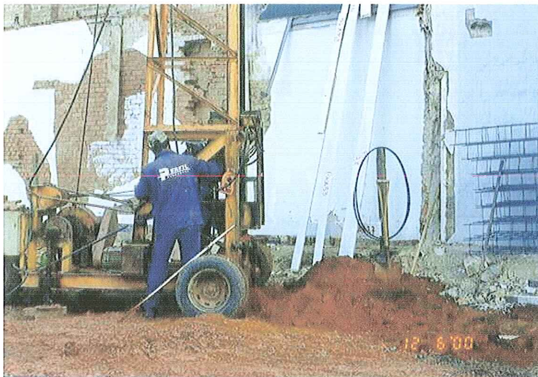
FIGURA 2.19 : Detalhe de equipamento (perfuratriz simples)
