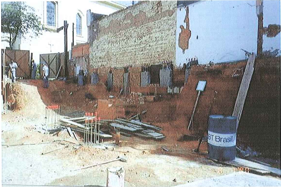
FIGURA 2.36 : Vista lateral esquerda da frente da obra
