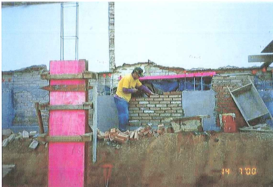
FIGURA 2.43 : Detalhe da execução da alvenaria de divisa.
