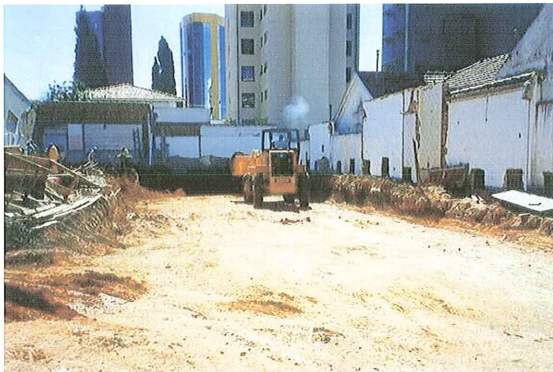
FIGURA 2.28 : Escavação do sub-solo
