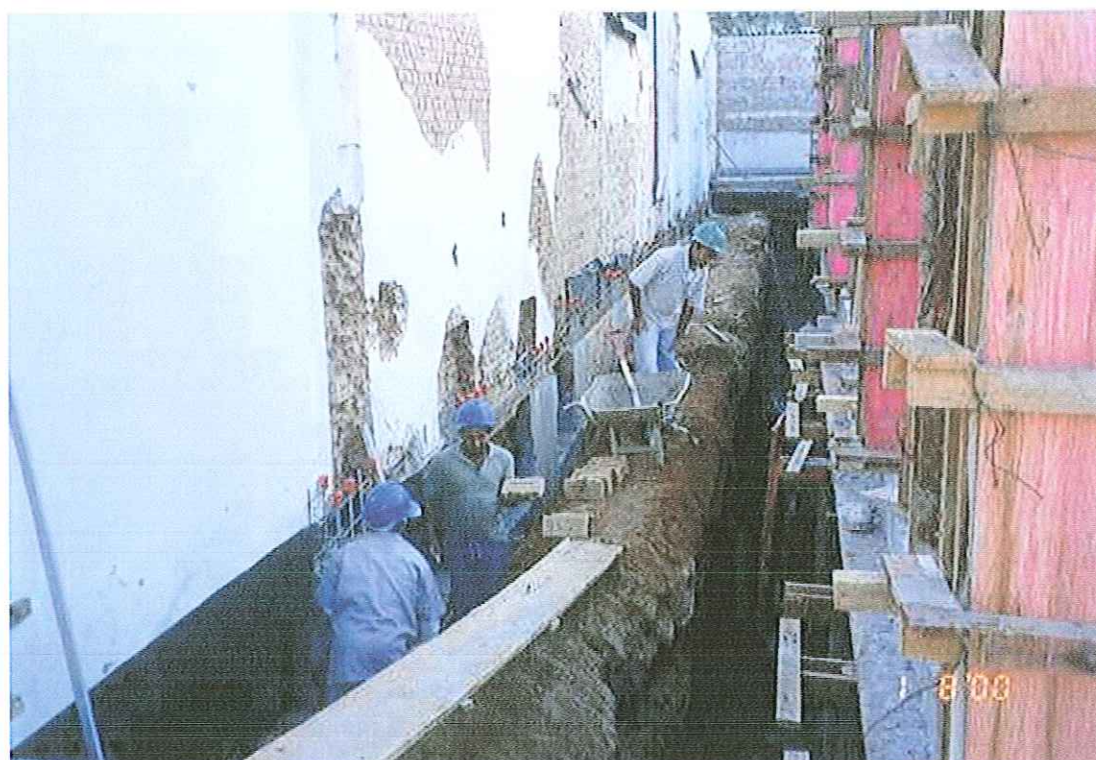
FIGURA 2.42 : Detalhe das vigas da divisa do lado esquerdo
