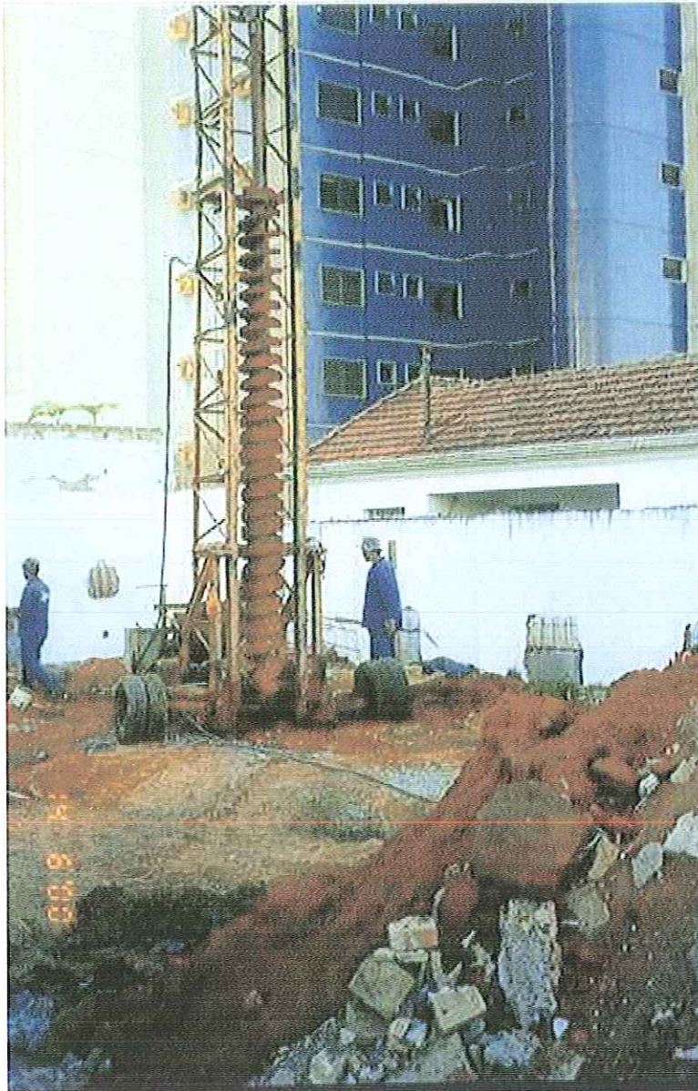
FIGURA 2.20 : Vista frontal do equipamento (perfuratriz)
