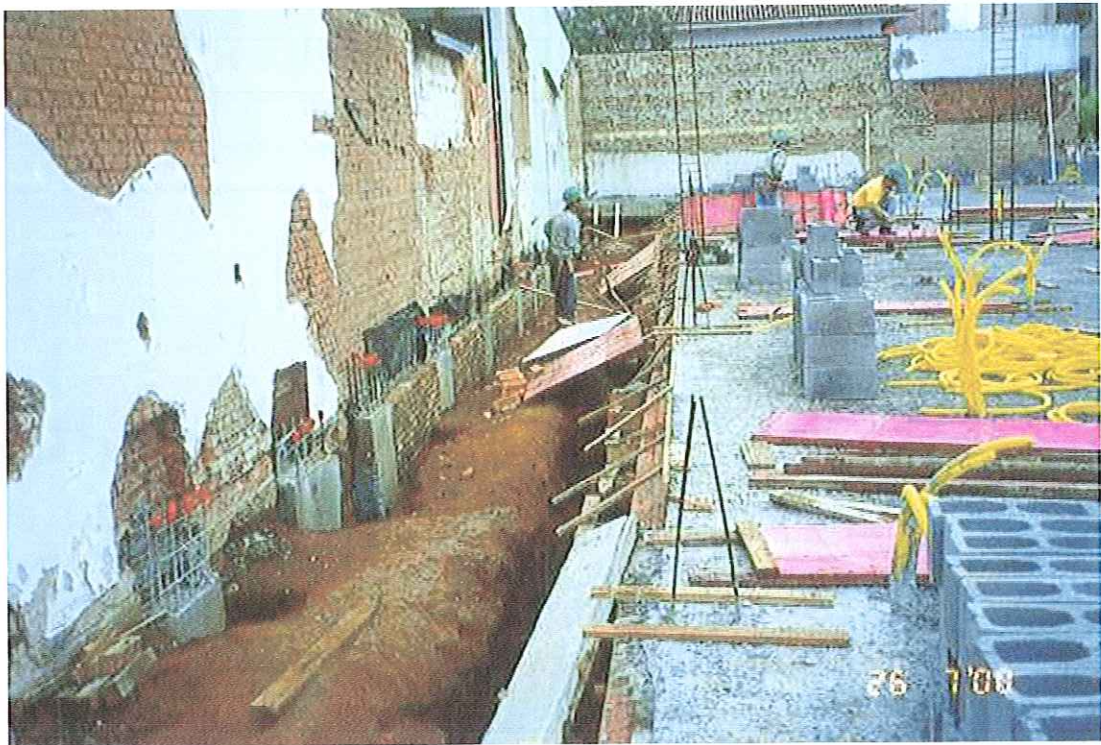
FIGURA 2.39 : Visão parcial da laje do lado direito
