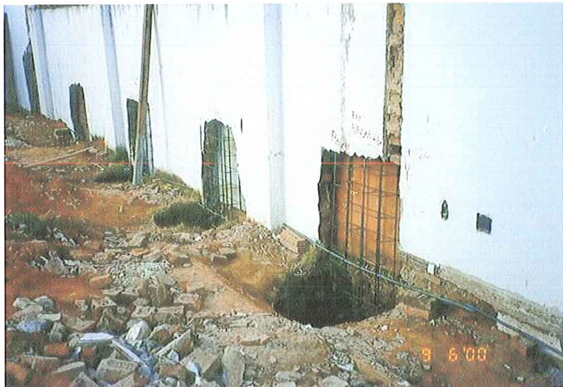
FIGURA 2.22 : Vista de varios tubulões de divisa com ferragem do pilar
