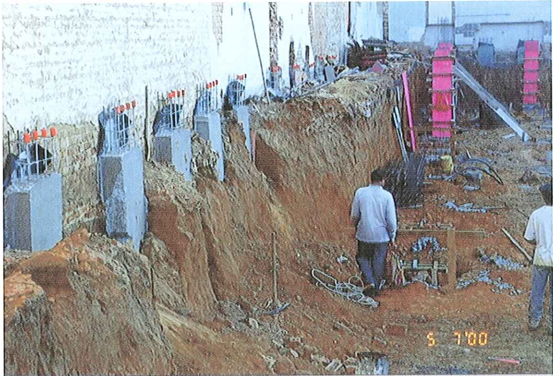
FIGURA 2.33 : Visão parcial da escavação do sub-solo e fôrmas dos pilares principais
