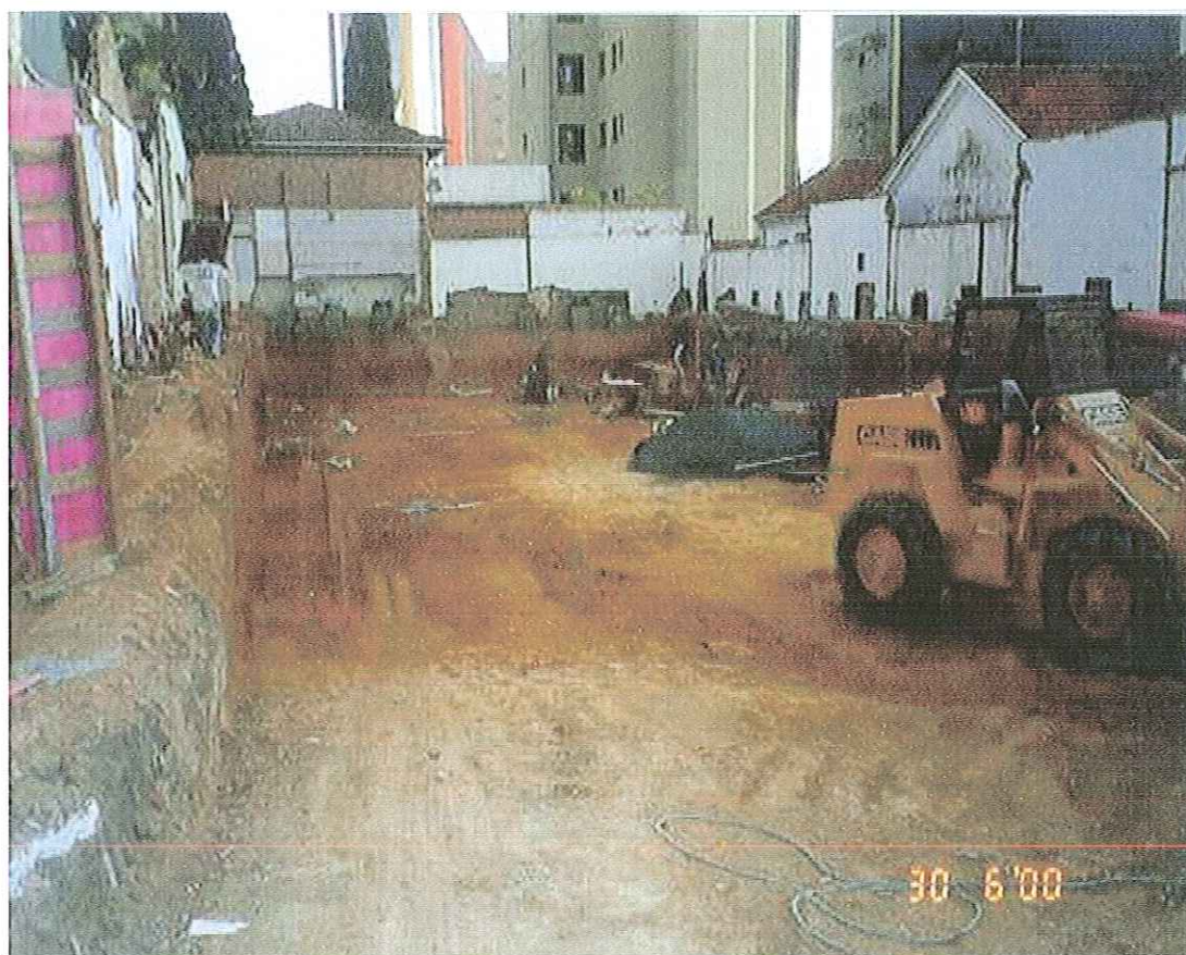
FIGURA 2.29 : Visão parcial da escavação do sub-solo
