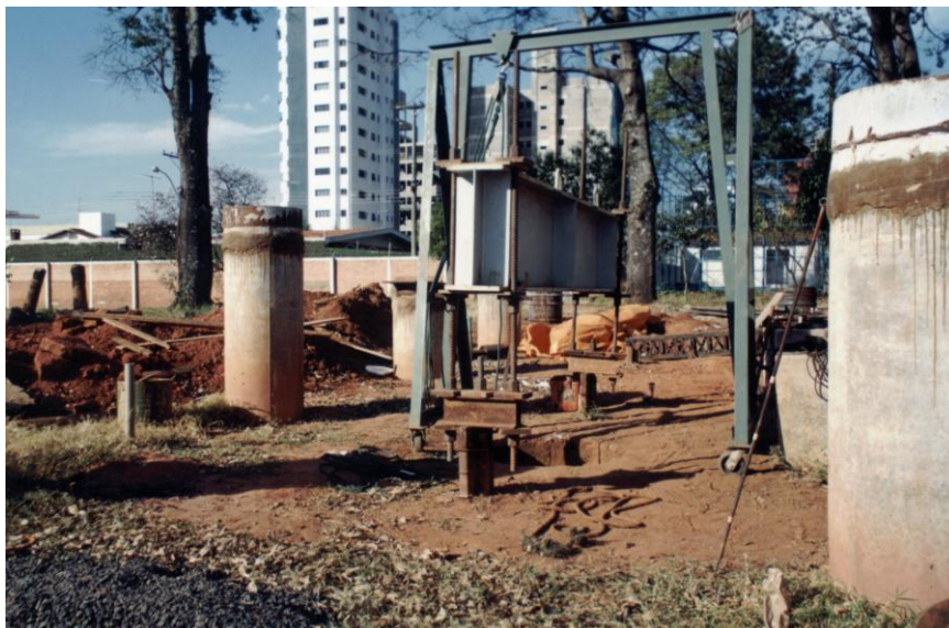
FOTO 07: Detalhe do pórtico utilizado para serviços diversos.
