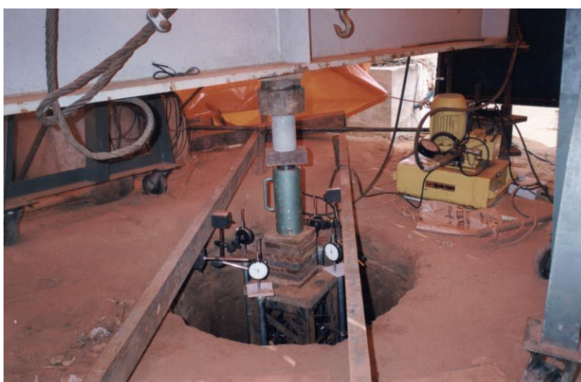
FOTO 06: Detalhe da bomba elétrica, macaco hidráulico, célula de carga e rótula.
