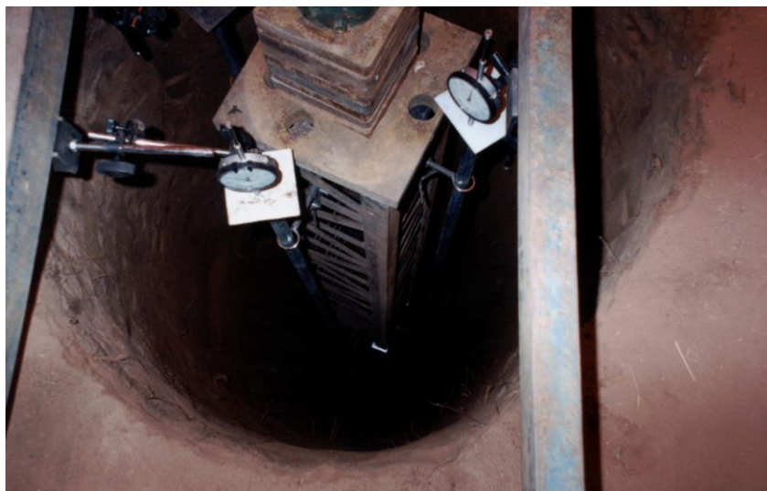
FOTO 05: Detalhe das hastes para medidas de recalque.
