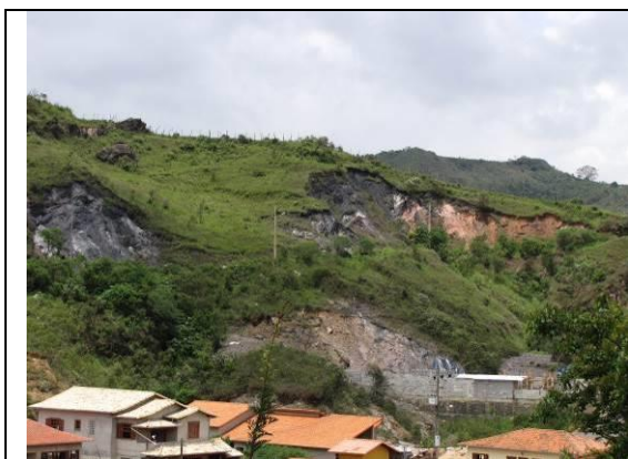
Figura 4. 31 – Deslizamentos a montante do Birro Jardim Alvorada, Ouro Preto, 2012.
