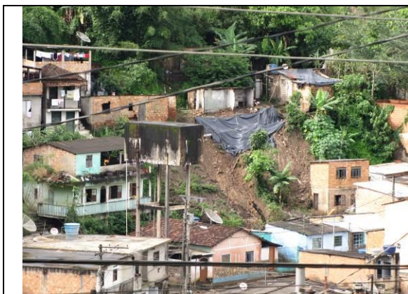
Figura 4. 11 – Deslizamento de solo no Bairro Santo Antônio, Mariana, 2012.
