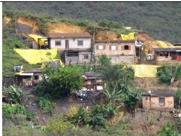
Figura 4. 13 – Deslizamento Bairro São Gonçalves, Mariana, 2012.
