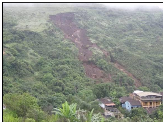
Figura 4. 29 - Deslizamento de solo / rocha. Distrito de Passagem de Mariana, charneira do Anticlinal de Mariana, 2012.
