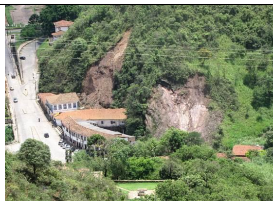
Figura 4. 32 – Deslizamento próximo à Rua dos Inconfidentes, Praça da Estação, Ouro Preto, 2012.
