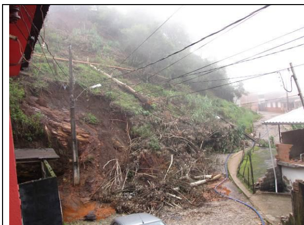
Figura 4. 15 – Deslizamento Rua Treze de Maio, Ouro Preto, 2012.
