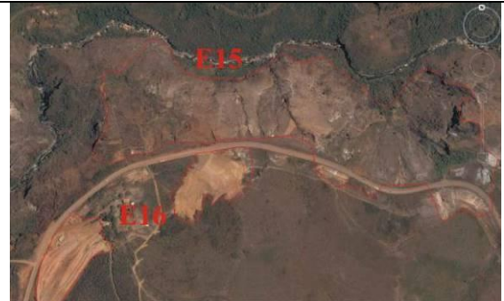
Figura 4. 24 - Processos erosivos e deslizamentos translacionais rasos de solo relacionados a retalhamentos em cortes da rodovia inadequados e ao lançamento das águas superficiais diretamente na encosta. Ausência de dispositivos de drenagem superficial nos taludes e de microdrenagem na rodovia. Ponto E15, E16, Ouro Preto – MG. Fonte: Google Earth, 2014.
