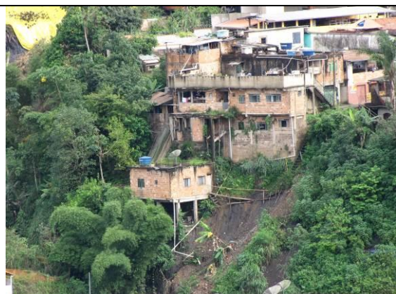
Figura 4. 12 – Deslizamento Bairro São Gonçalves, Mariana, 2012.
