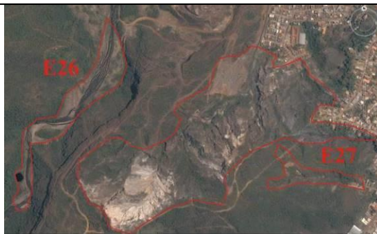
Figura 4. 25 - Solo exposto. Área não ocupada. Contato entre os filitos fraturados e alterados da Formação Cercadinho com os filitos da Formação Barreiro. Processos erosivos lineares ativos e deslizamentos translacionais de solo e rocha constantes. No ponto E26 tem-se uma intensa deposição de sedimentos e formação de barras laterais com o frequente retrabalhamento das mesmas nos períodos de elevação das vazões. Pontos E26, E27, Mariana – MG. Fonte: Google Earth, 2014.
