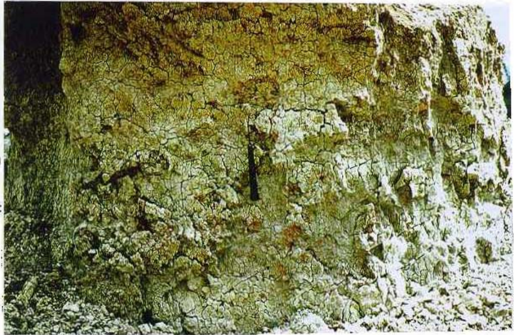
Figura 2.24 - Aspecto do empastilhamento e trincas causados pela retração nas argilas cinza-esverdeadas da Formação Guabirotuba (Felipe et al. , 1994)
