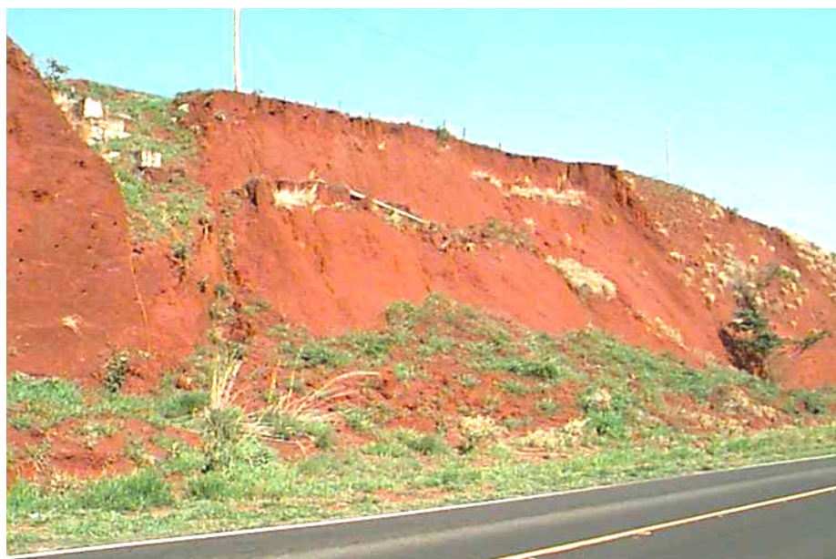
FIGURA 3.2- Vista do talude escorregado.
