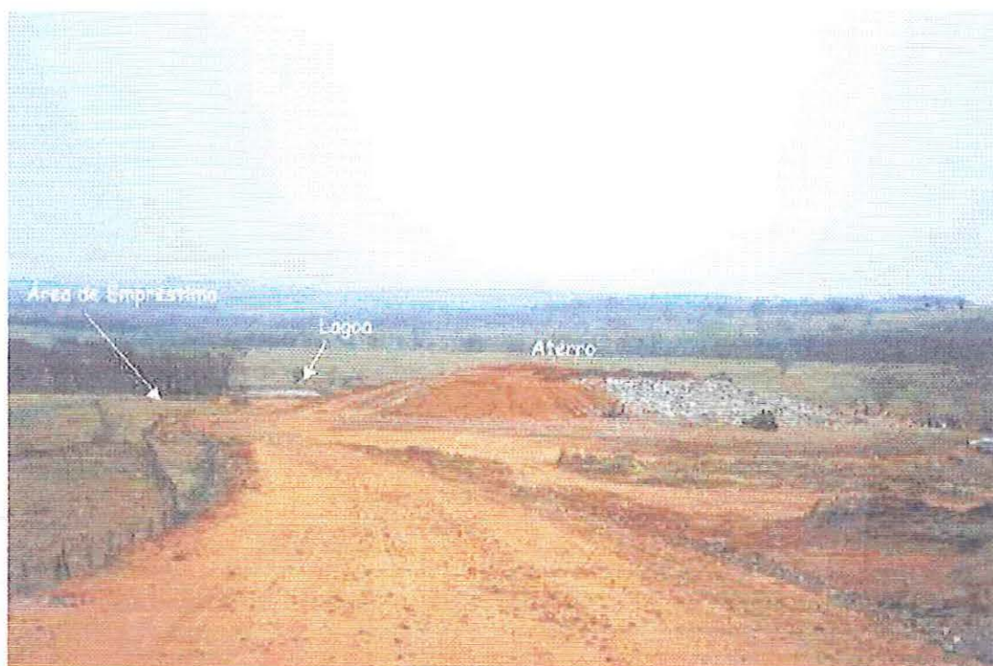
FIGURA 33. Visão geral do aterro sanitário.
