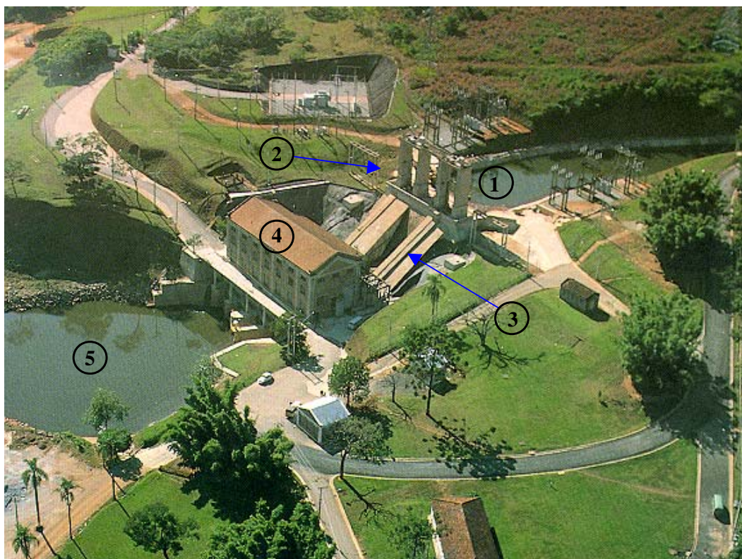
FIGURA 38 – Vista geral do conjunto de geração da Usina de Rasgão. Da direita para a esquerda: (1) canal de adução, (2) tomada d'água da usina, (3) condutos forçados, (4) casa de força e (5) canal de fuga.
