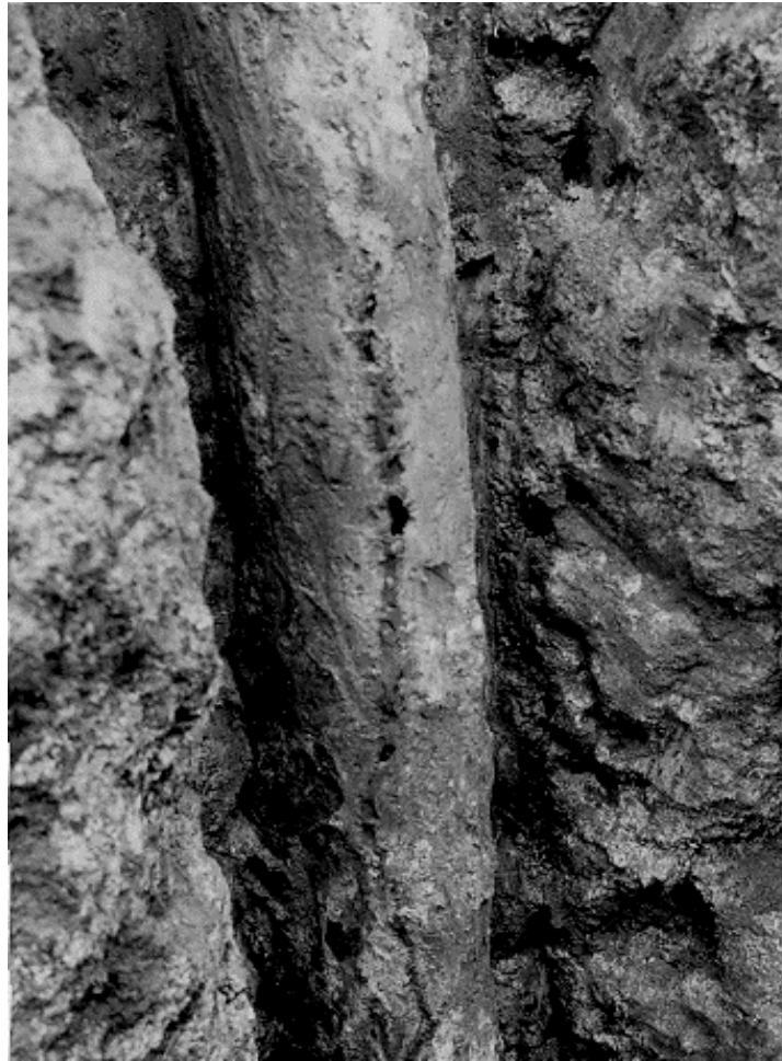
FIGURA 67 – Imagem extraída da bainha de um furo no campo de prova. Observar a calda endurecida na vertical contendo pontos escuros (vazios).
