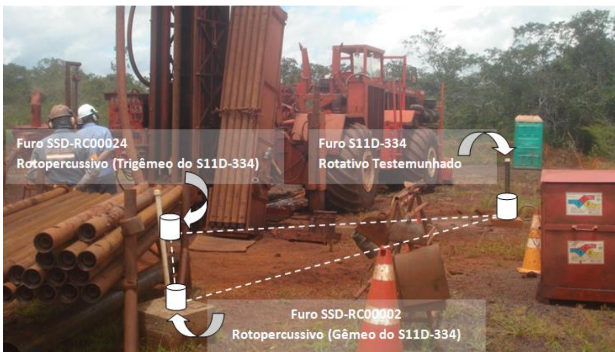
Figura 5.1– Distribuição dos furos de sondagem rotopercussivo e rotativo testemunhado na mesma praça
