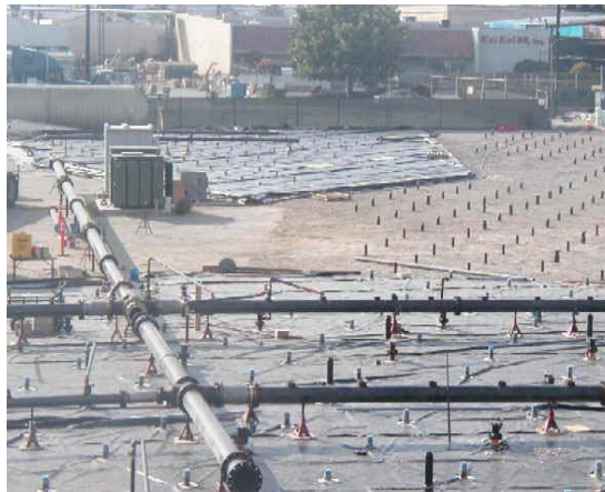
Figura 2.19 – Instalação da instrumentação e das tubulações (1) (Bierschenk et al , 2004)
