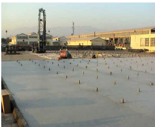
Figura 2.16 – Instalação dos bastonetes (1) (Bierschenk et al , 2004)
