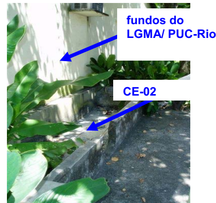
Figura 4.60 – Local dos experimentos, com laje de concreto (2)
