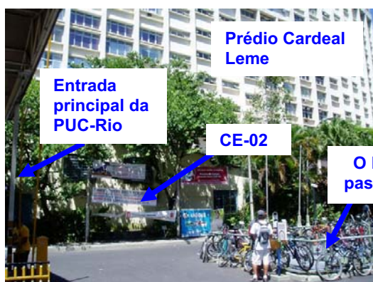
Figura 4.57 – Vista da CE-02, próxima à entrada principal da PUC-Rio (1)
