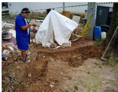
Figura 4.39 – Abertura de trincheira (2)
