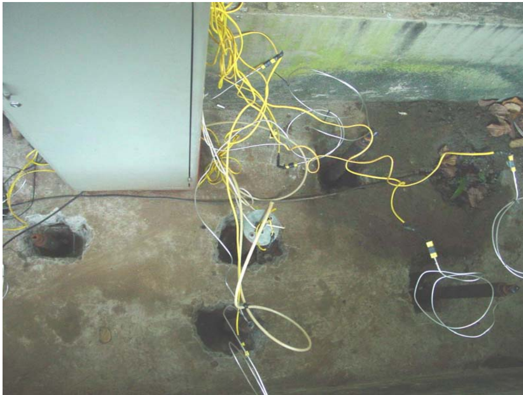
Figura 4.66 – Instalação do sistema de dessorção térmica in situ
