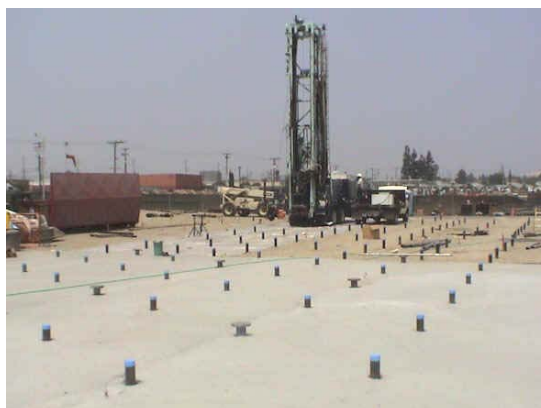
Figura 2.17 – Instalação dos bastonetes (2) (Bierschenk et al , 2004)
