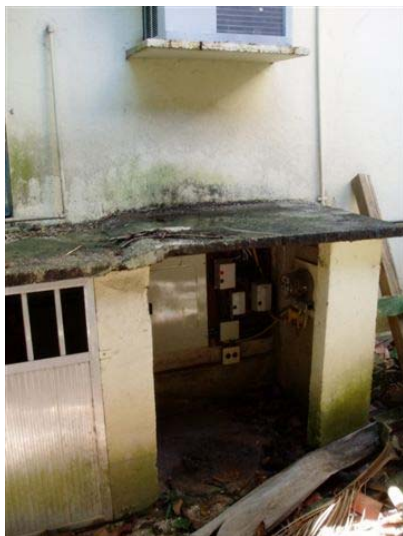
Figura 3.22 – Local da instalação elétrica, no LGMA/PUC-Rio , para os sistemas de dessorção térmica
