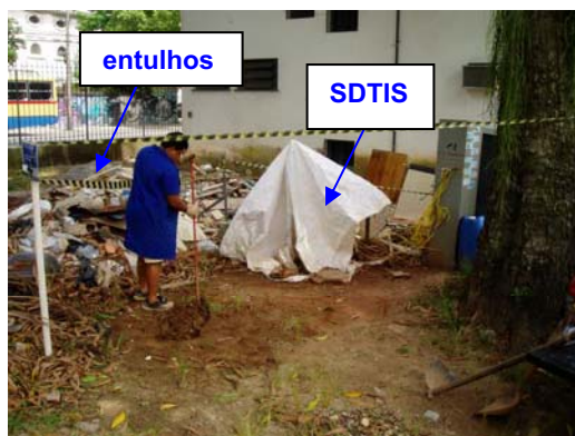
Figura 4.38 – Abertura de trincheira (1)
