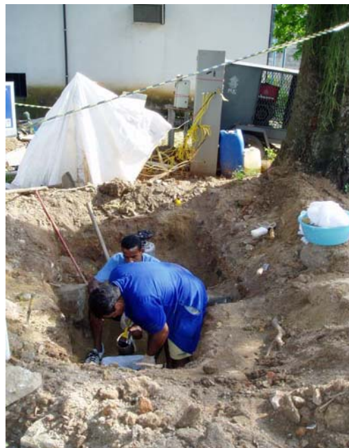
Figura 4.47 – Vista geral do serviço de extração do bloco de solo
