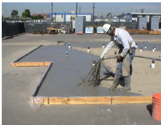
Figura 2.22 – Instalação de uma emulsão, utilizado como isolamento da superfície (TerraTherm Inc.)
