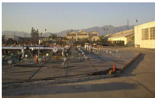
Figura 2.25 – Área da figura anterior, durante o tratamento (TerraTherm Inc.)
