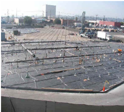
Figura 2.18 – Instalação de um material isolante na superfície do terreno (Bierschenk et al , 2004)
