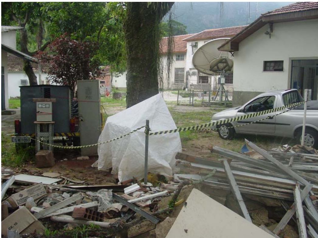
Figura 4.36 – Vista do CE-01, mostrando grande parte da área tomada por entulhos
