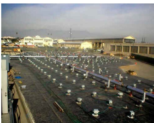
Figura 2.20 – Instalação das tubulações (1) (Bierschenk et al , 2004)
