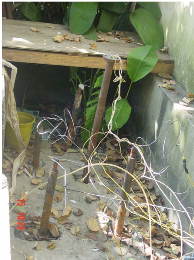
Figura 4.85 – Instalação dos componentes do novo SDTIS no CE-02
