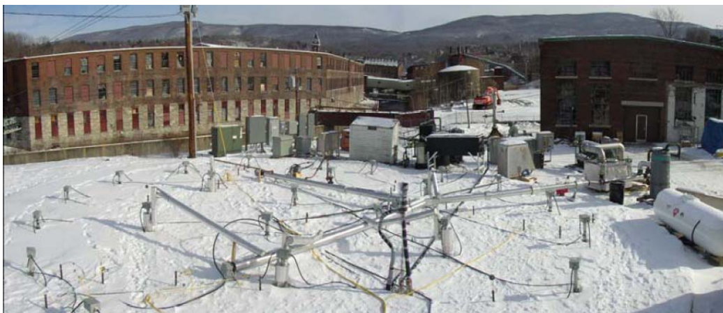
Figura 2.14 – Fotografia da área de aplicação do sistema de dessorção térmica in situ (Baker et al , 2004)
