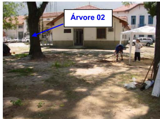
Figura 4.14 – Vista geral dos serviços de sondagens realizados no CE-01
