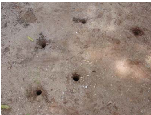
Figura 4.21 – Furos de 2” já executados
