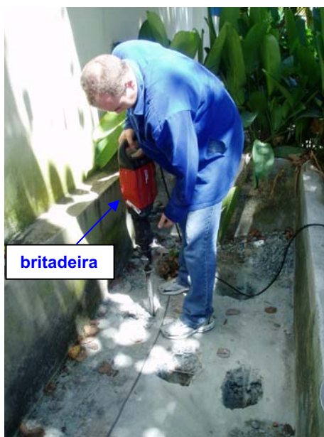
Figura 4.61 – Perfuração da laje de concreto com a britadeira
