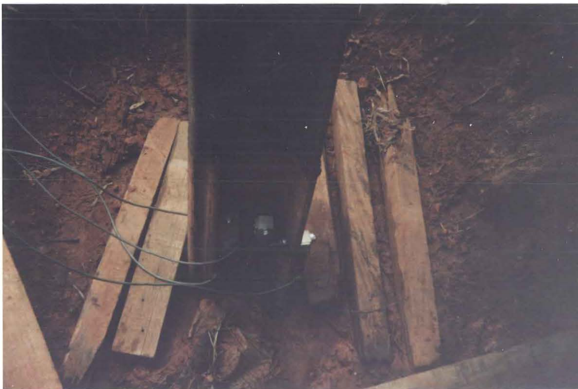
Figura 3.2 – Prova de carga dinâmica realizada no Campo Experimental da USP/São Carlos.
