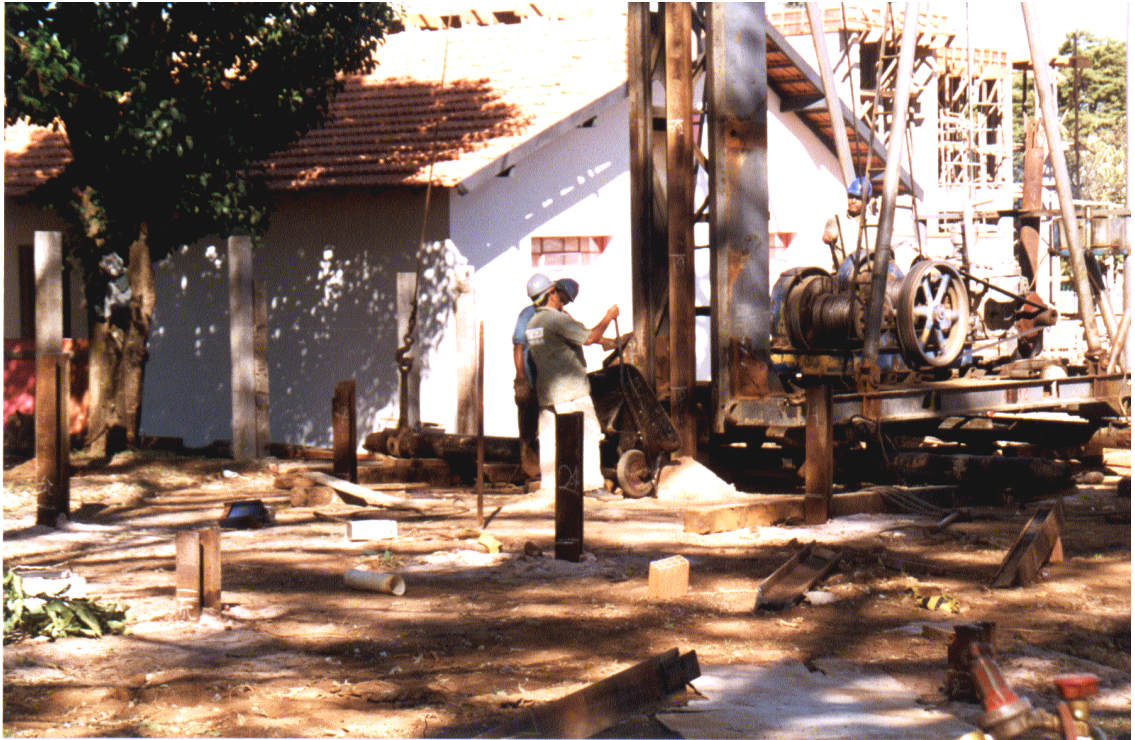
Foto 01. Bate-estaca na etapa final da cravação das estacas de reação.
