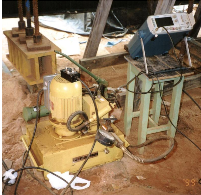
Foto 10. Bomba elétrica de pressão tipo Yellow Power, aparelho de TDR e um dos quatro perfis inferiores do sistema de travamento da viga.
