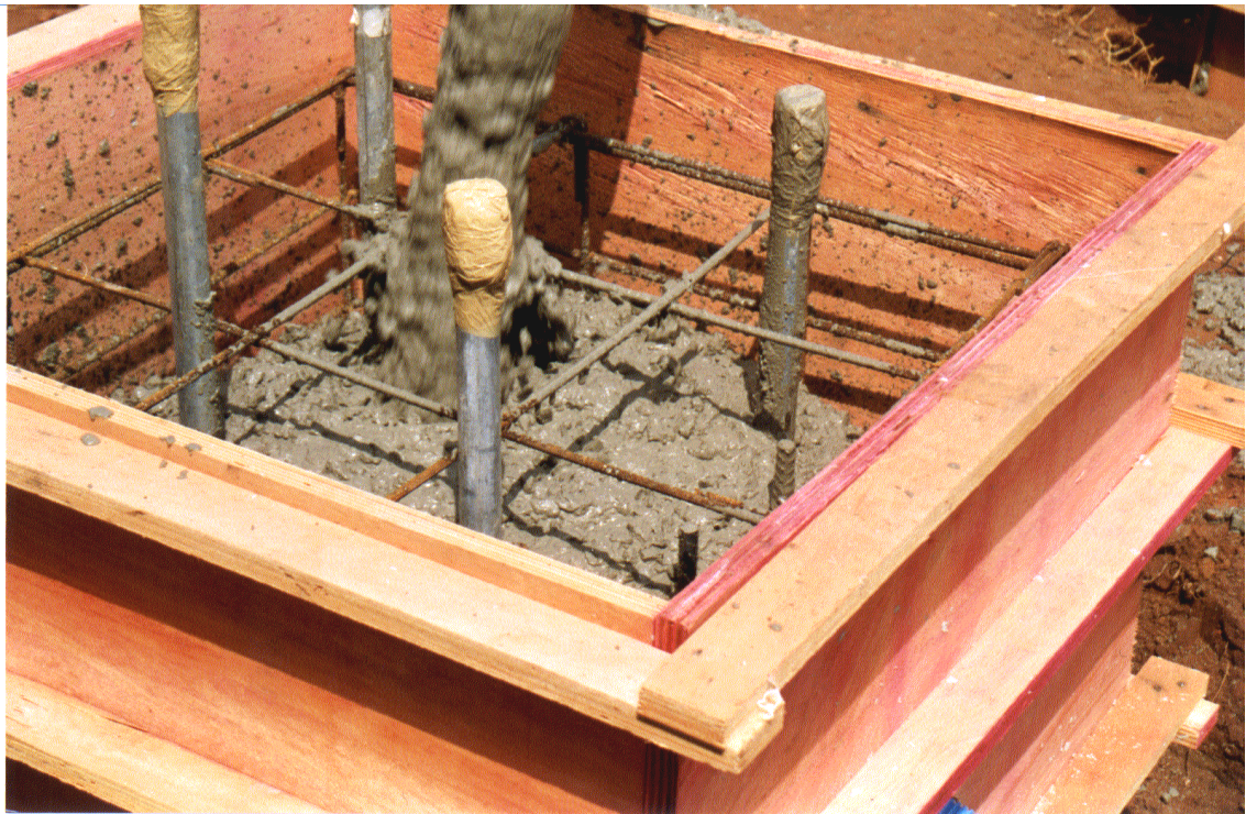
Foto 06. Concretagem final dos tubulões, onde se pode observar a armadura e a forma do bloco recebendo concreto.
