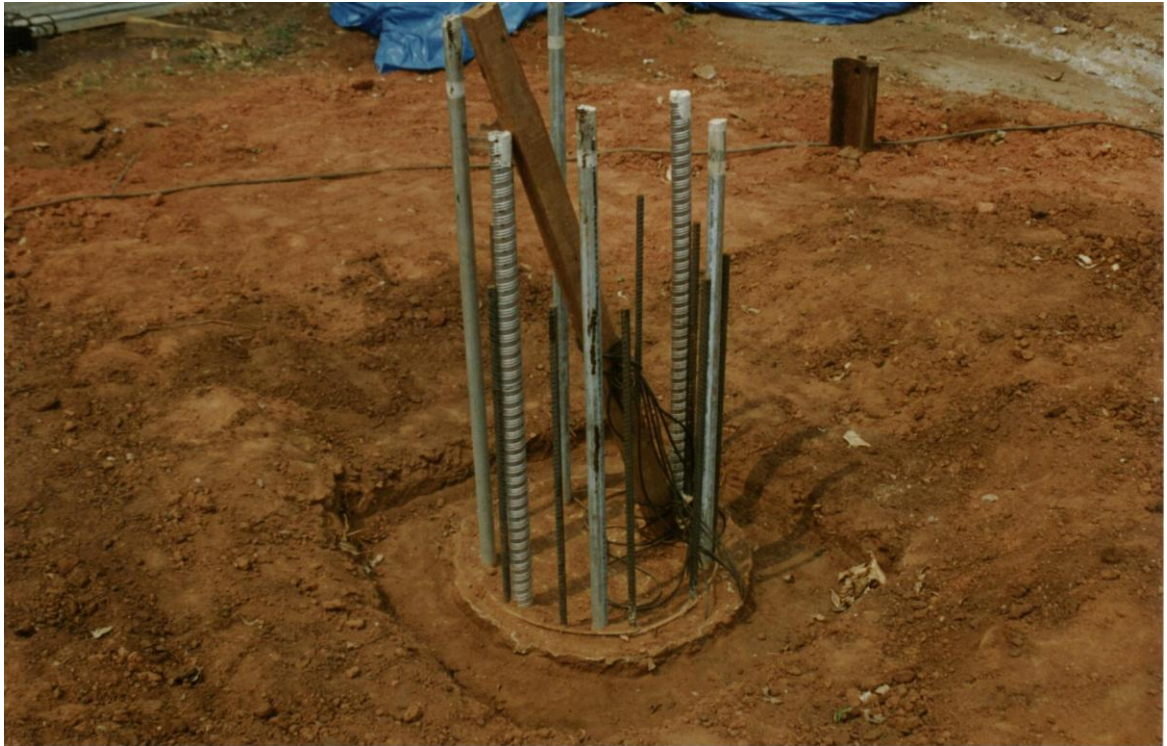
Foto 7. Tubulão já concretado com os tubos de espera para tell-tales (tubo galvanizado) e das bainhas de protensão para os strain-gages .
