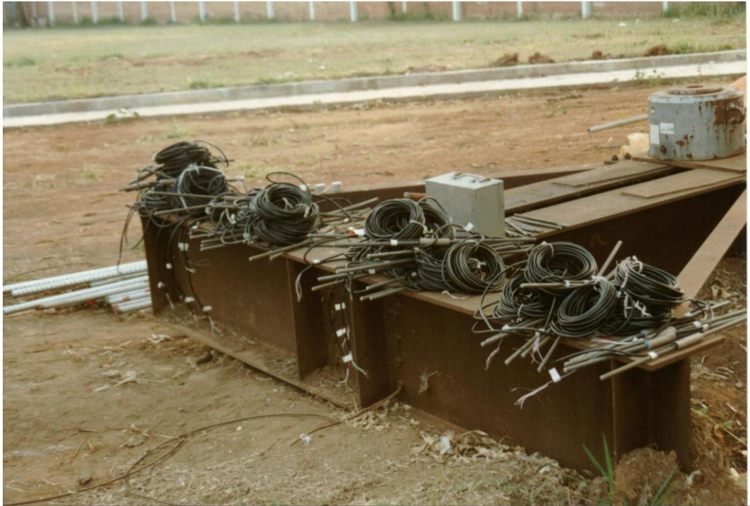
Foto 8. Vista parcial da viga de reação.
