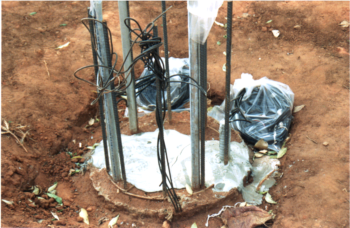
Foto 05. Estado final de instalação dos tubos de espera dos tell-tales e das linhas de strain-gages .
