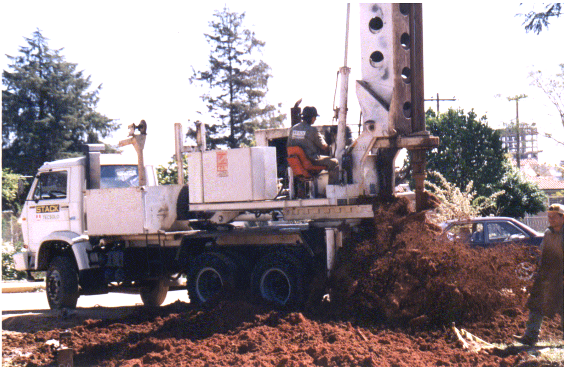
Foto 02. Equipamento de perfuração mecanizado dos fustes dos tubulões.
