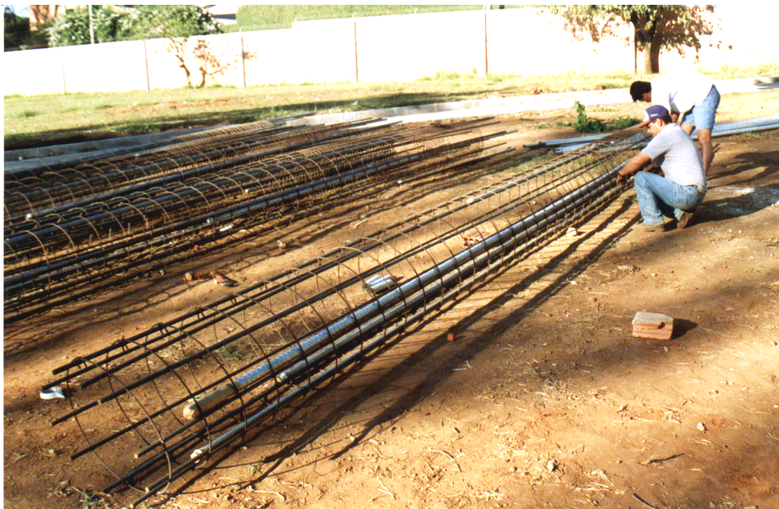
Foto 03. Armadura com os tubos de espera da instrumentação de tell-tales e strain-gages .
