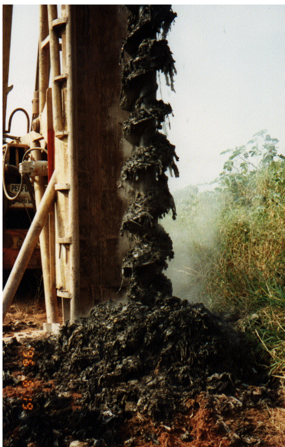
Figura 3.2 – Tradagem mecânica com trado helicoidal de 40 cm de diâmetro.
