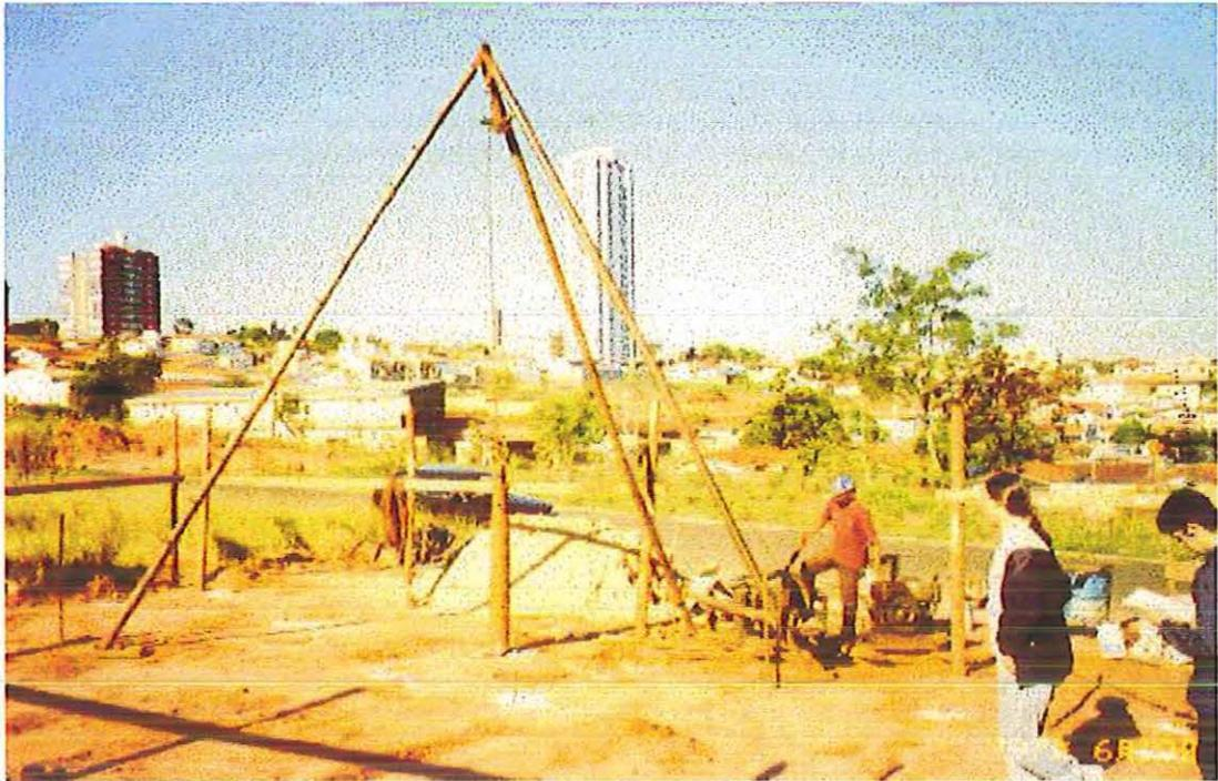
**FOTO 2.01: Vista do conjunto de acionamento/deslocamento do soquete.**
