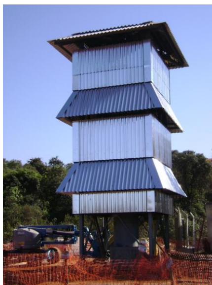
Figura 33. Campo de Aferição Gama-Gama construído pela Vale com certificação do IPT.
