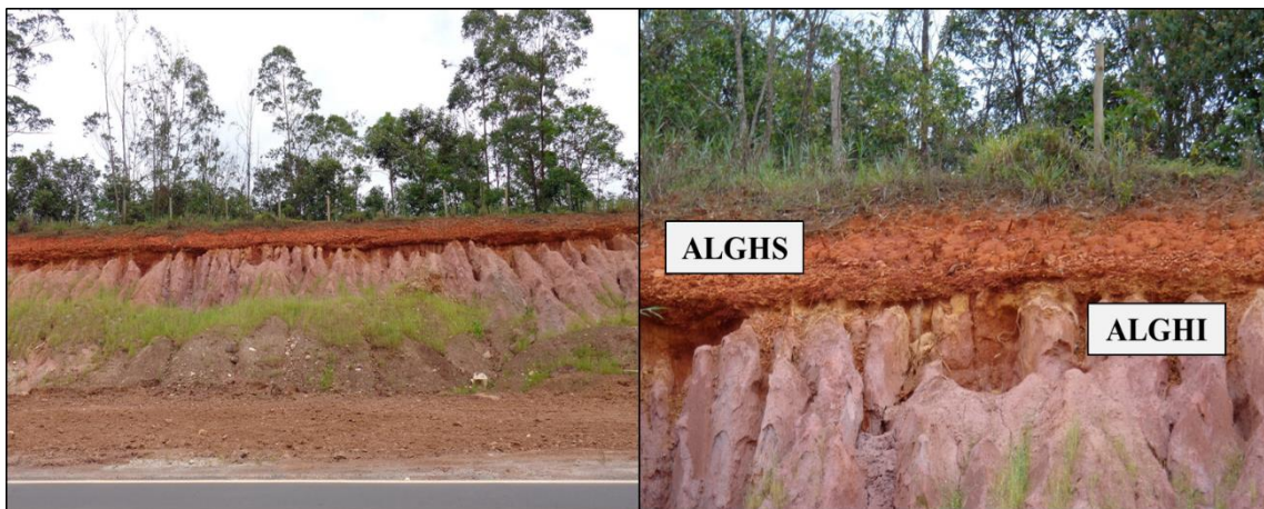
Figura 3.12 – Talude próximo à mina de Alegria (ALG).
