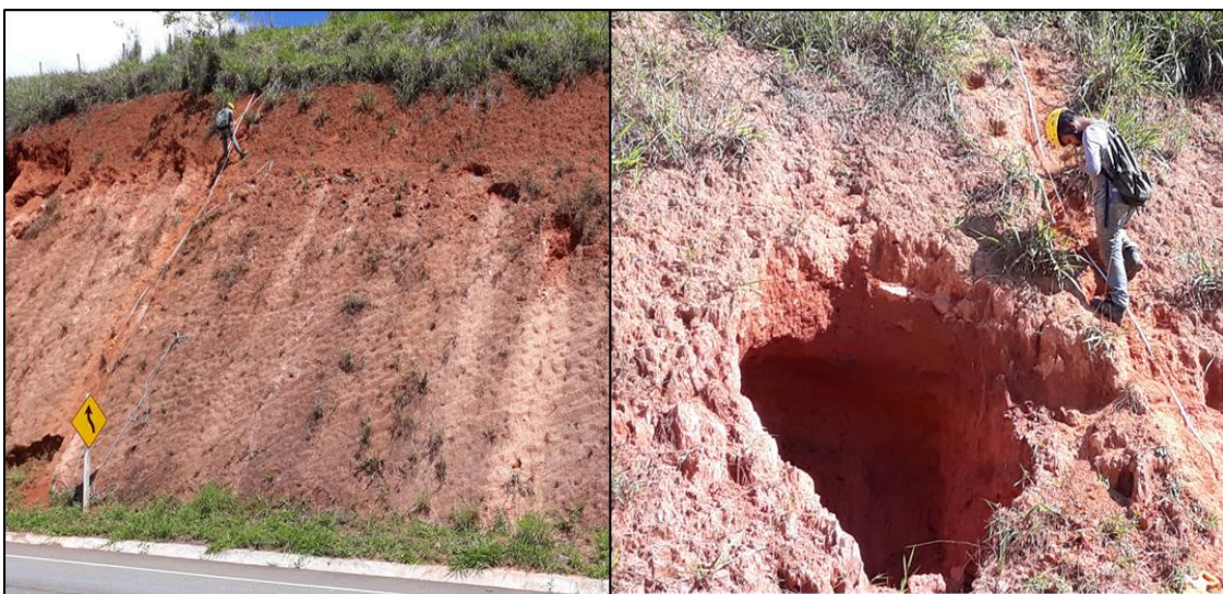
Figura 4.1 – Inspeções de campo.
