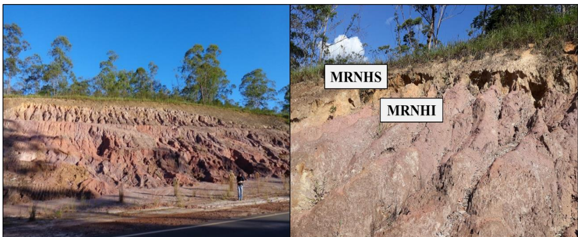
Figura 3.10 – Talude localizado em Mariana - MG (MRN).
