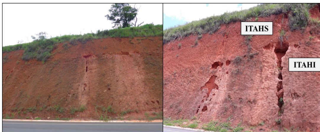
Figura 3.4 – Talude localizado próximo ao município de Itabira-MG (ITA).
